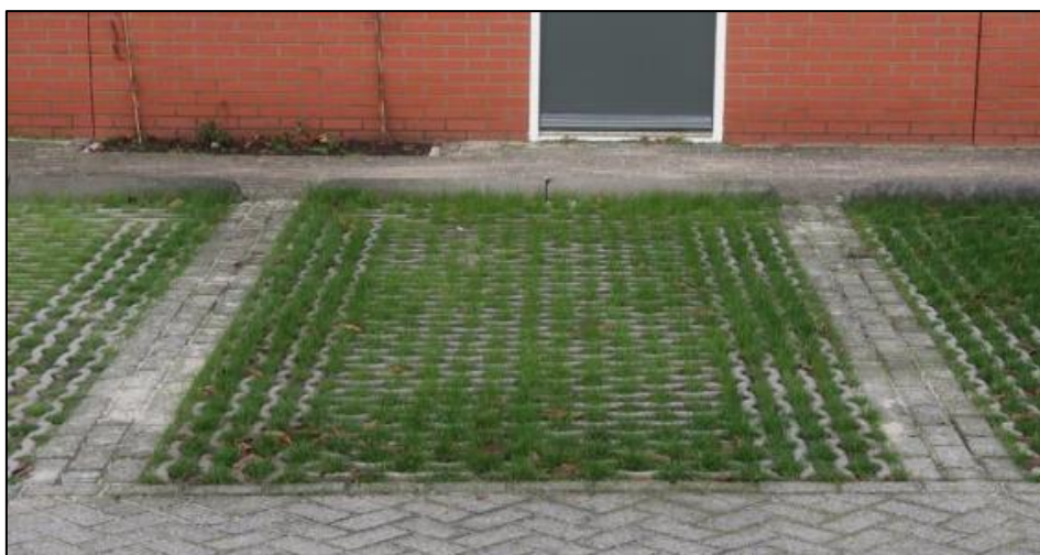
Figuur 11: Halfverharding bij parkeerplaatsen (bron:duurzaamdenhaag.nl).
