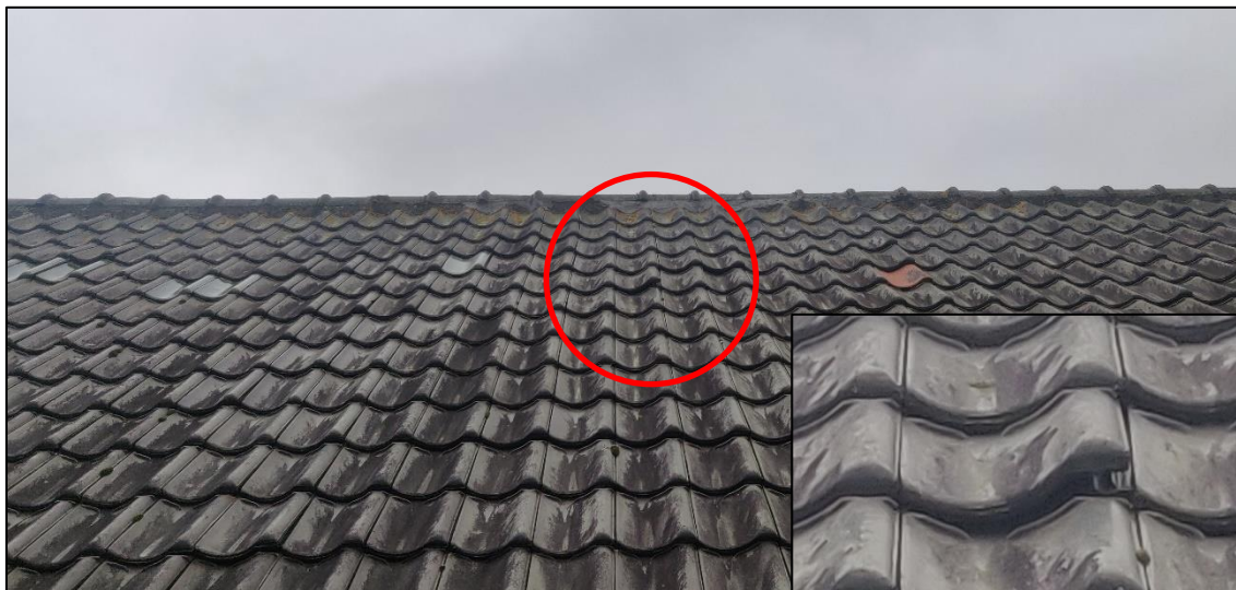
Figuur 9: Een van de scheefliggende dakpannen op het middendak. Inzet: Close-up van de scheefliggende dakpan.
