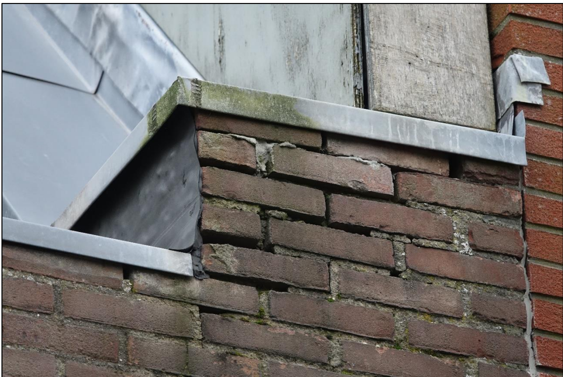
Figuur 11: Wijkende daklijsten bieden dwergvleermuizen toegang tot een verblijfplaats.
