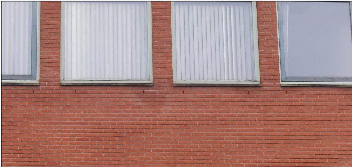
Figuur 10: In alle aanwezige gevels zijn open stootvoegen aanwezig waar vleermuizen een verblijfplaats kunnen hebben..
