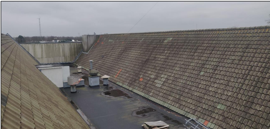
Figuur 5: De ruimte tussen de dubbele zadeldaken boven het leegstaande bedrijfspand.
