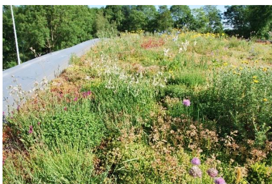
Afbeelding 7: kruidenrijk groen dak
