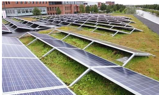
Afbeelding 3: PV-panelen i.c.m. groen dak
