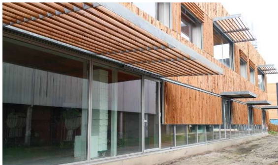
Afbeelding 2: overstekken aan gebouw
