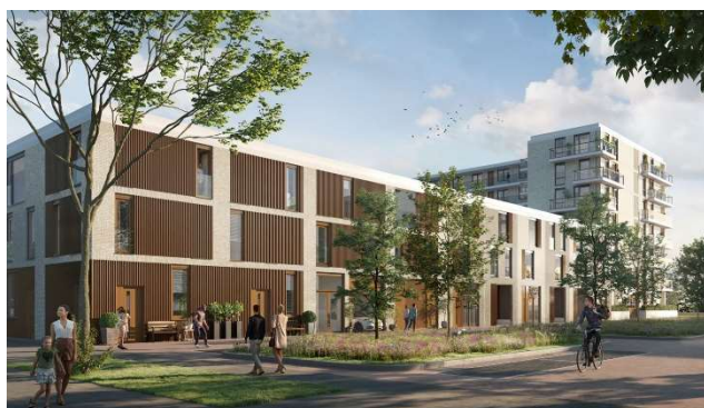
Afbeelding 8: gedeeltelijk houten gevel
