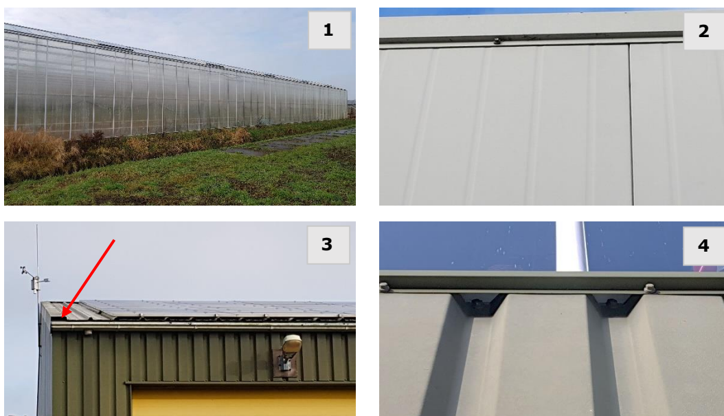
Foto's van de kas (1), de dakrand van de koelcel (2), de voorkant dan de loods (3, rode pijl toont opening) en zijkant van de loods (Foto's Laneco, 2020)
