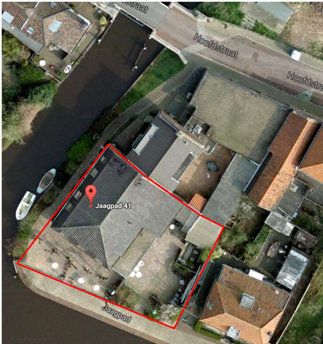
Bestaande situatie Jaagpad 41 te Leiderdorp
