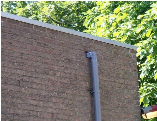
e) kier bij regenwaterafvoer.
