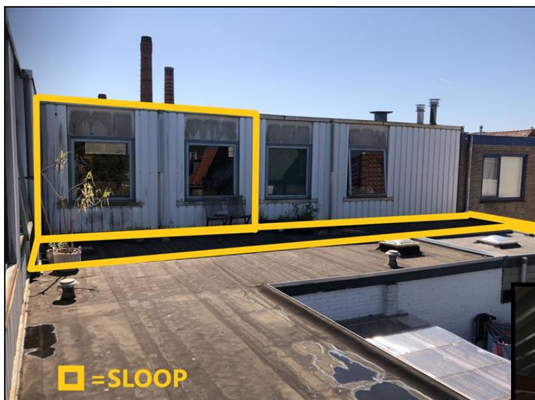
Afbeelding: de foto links toont het bouwdeel dat gesloopt zal worden en geeft de muren van de gebouwen weer. Zichtbaar is dat de muren gesloten zijn en geen kieren en gaten bevatten.
