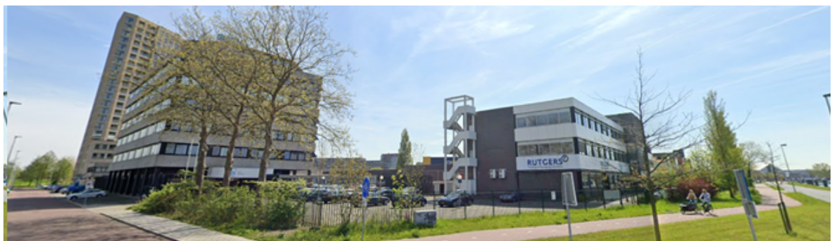
Figuur 2.1. Afbeelding Google Streetview, huidige situatie bekeken vanaf de Zijldijk / Leidsedreef
