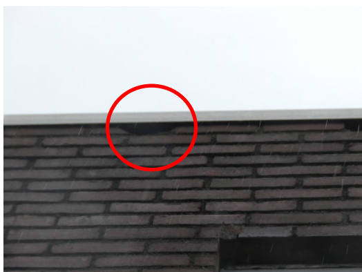
Foto 5: ruimte bij daktrim
