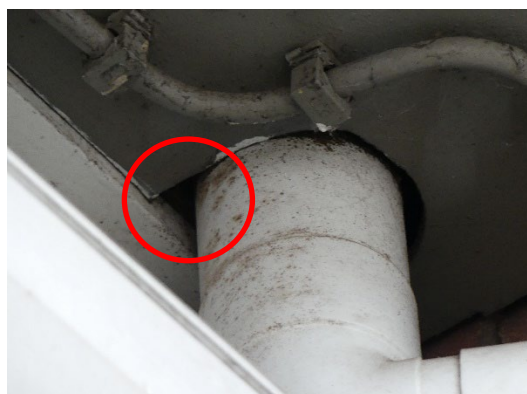
Foto 6: ruimte bij regenpijp
