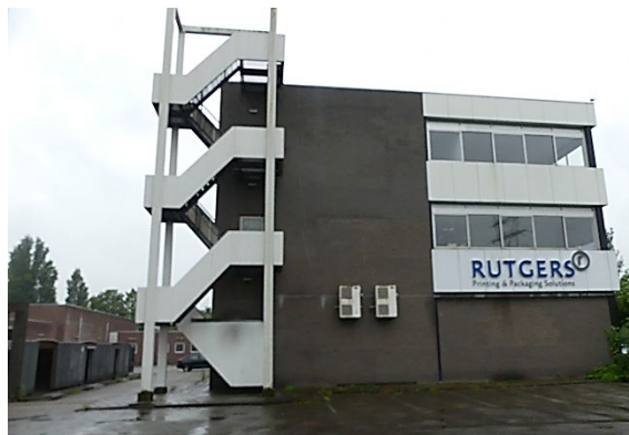
Foto 2: aanzicht lagere kantoorgebouw
