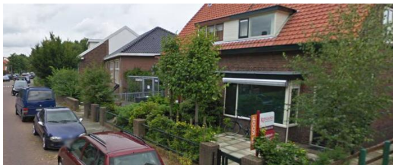
Te slopen woningen met op de achtergrond het huidige schoolgebouw
