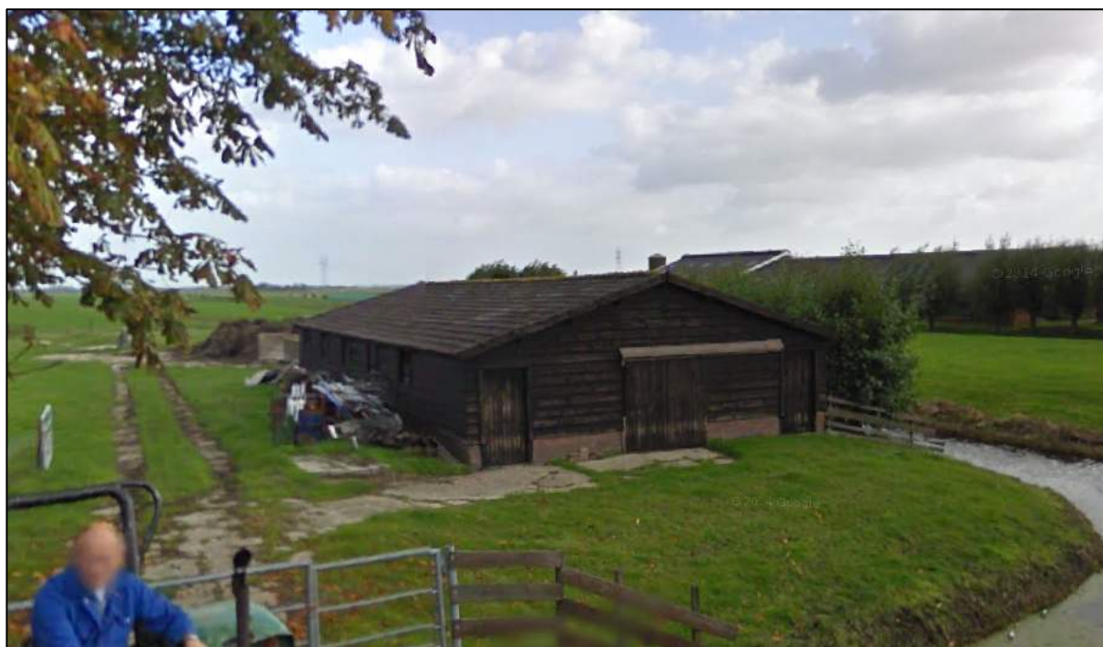
Afbeelding 4.12: De te saneren melkschuur, bouwwerken en verharding.
