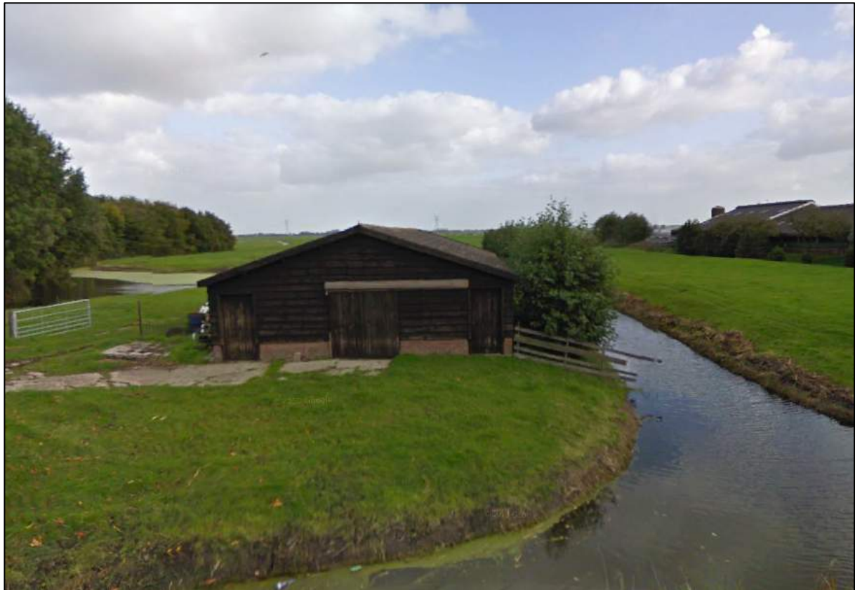
Afbeelding 2.11: Bestaande melkschuur welke geamoveerd zal worden. Het achterliggende landschap komt in dit geval zichtbaar.
