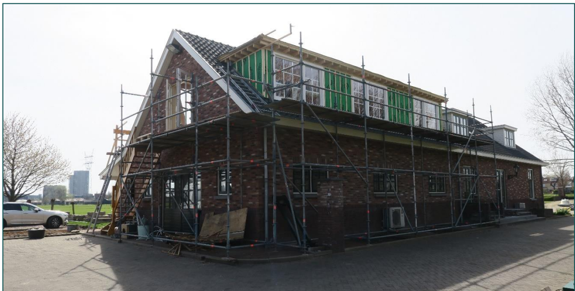
Figuur 1.3 De noordwestzijde van de woning, aan deze zijde zal de uitbreiding gerealiseerd worden.
