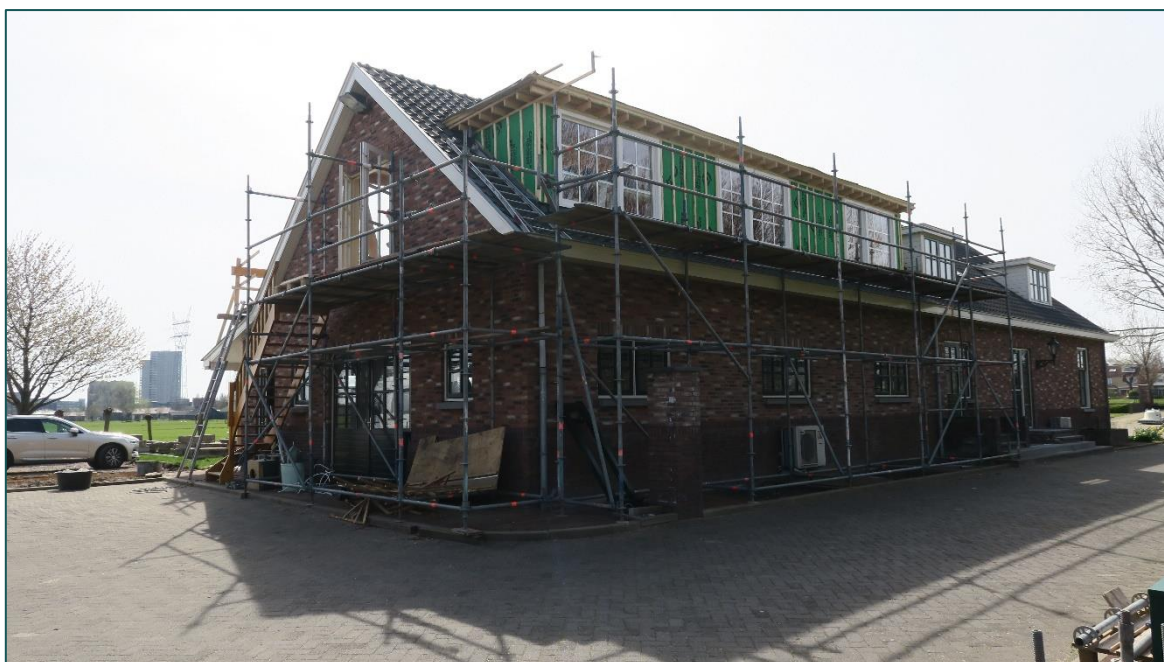
Figuur 2 De noordwestzijde van de bebouwing, aan deze zijde zal de uitbreiding gerealiseerd worden.
