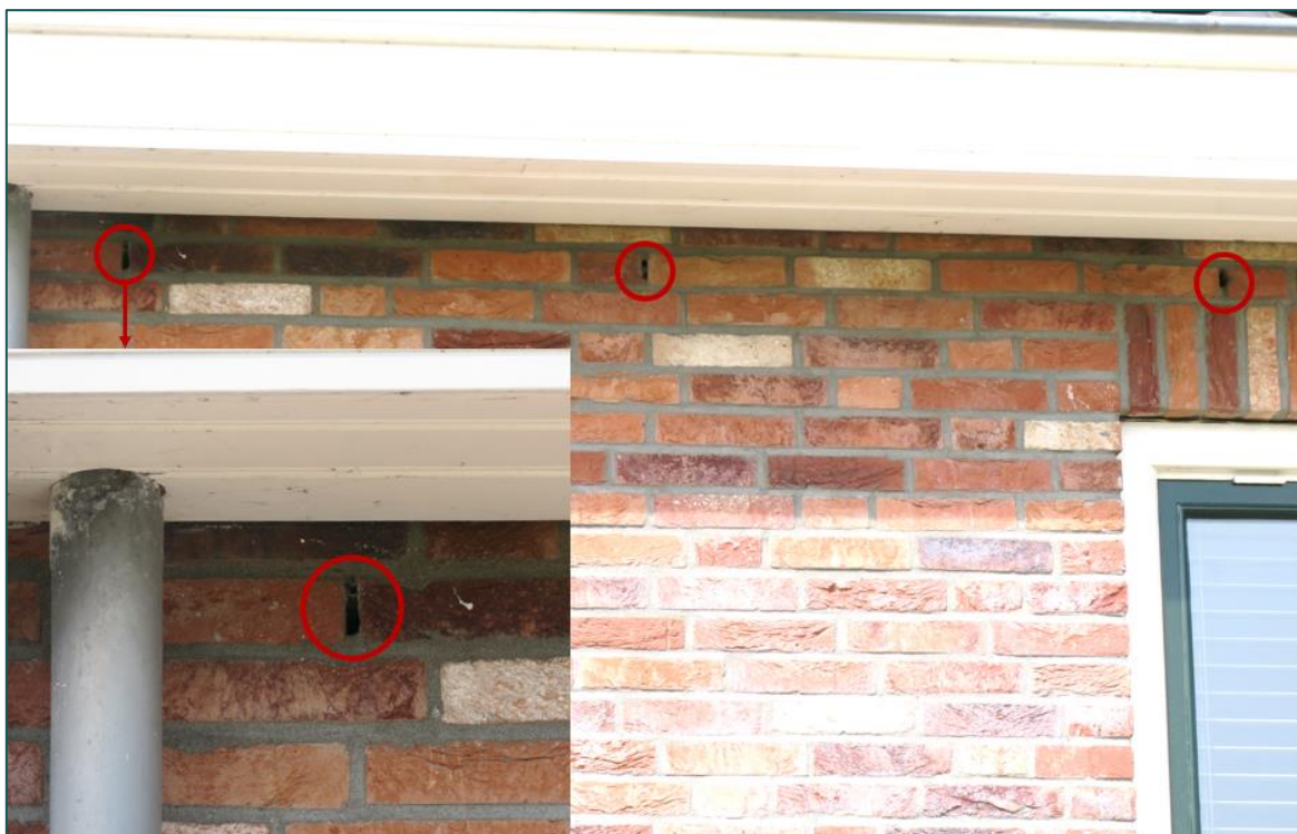
Figuur 3.1 De luchtpouw is voor vleermuizen toegankelijk via stootvoegen.
