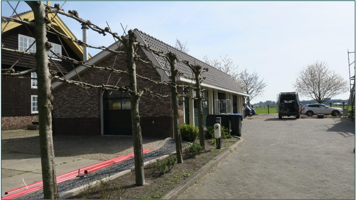
Figuur 3 De schuur welke inpandig verbouwd zal worden.
