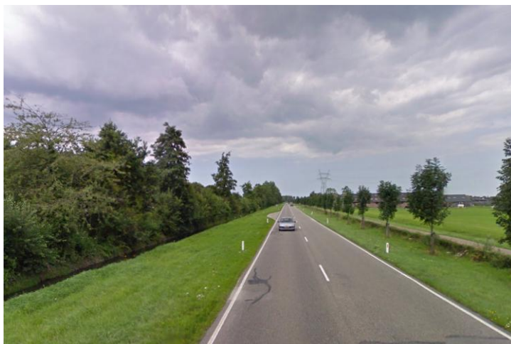
N446A gezien in noordelijke richting
