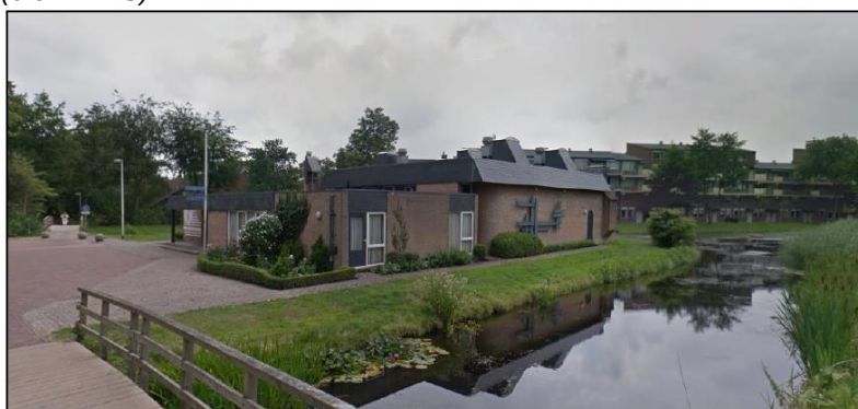
Het voormalige kerkgebouw gezien vanaf brug Heelblaadjespad (bron: Google Maps)
