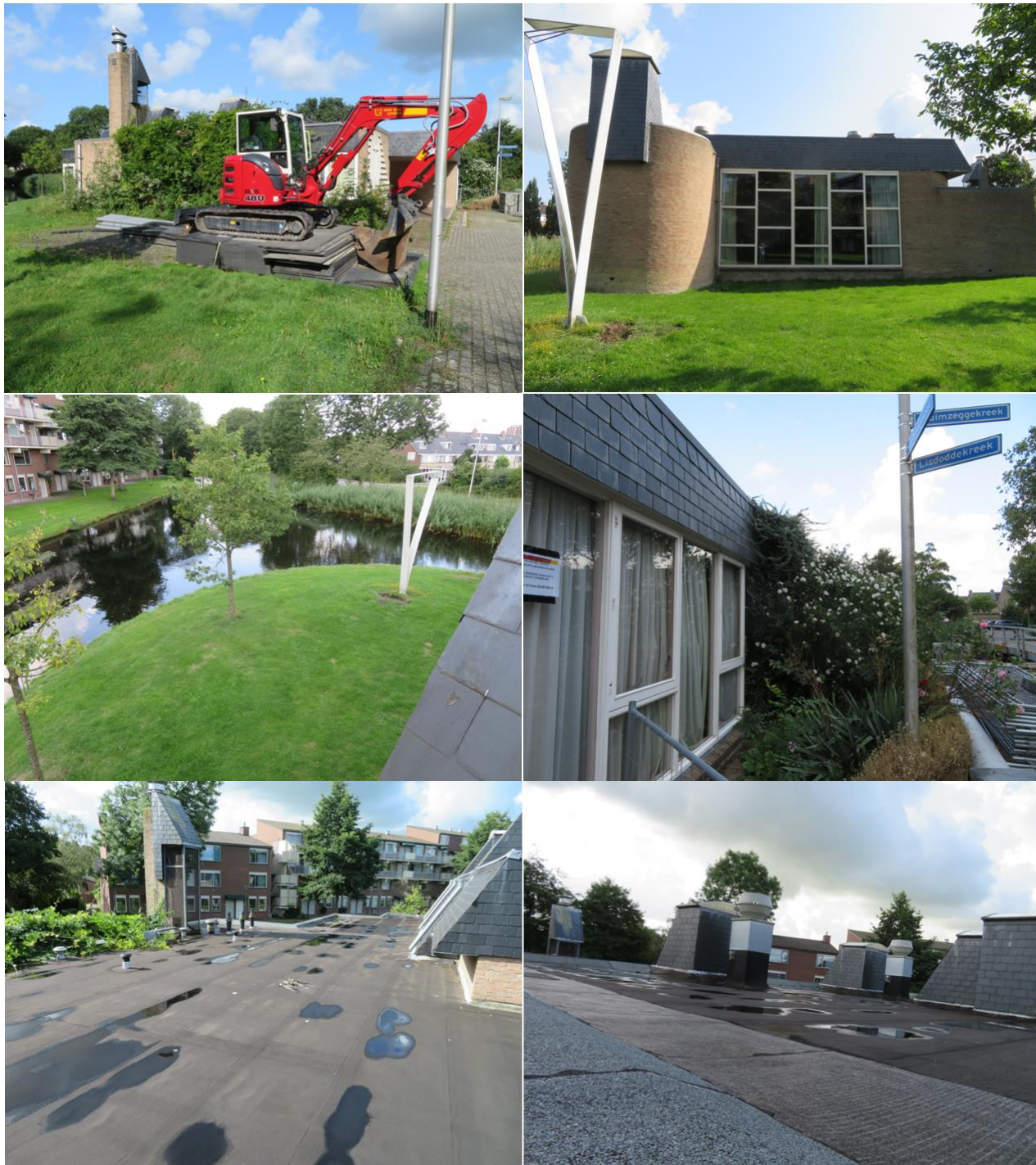
Foto's plangebied: oostgevel, zuidgevel, foto vanaf dak zuidgevel naar water, voorgevel, dak, dak hoge gedeelte.
