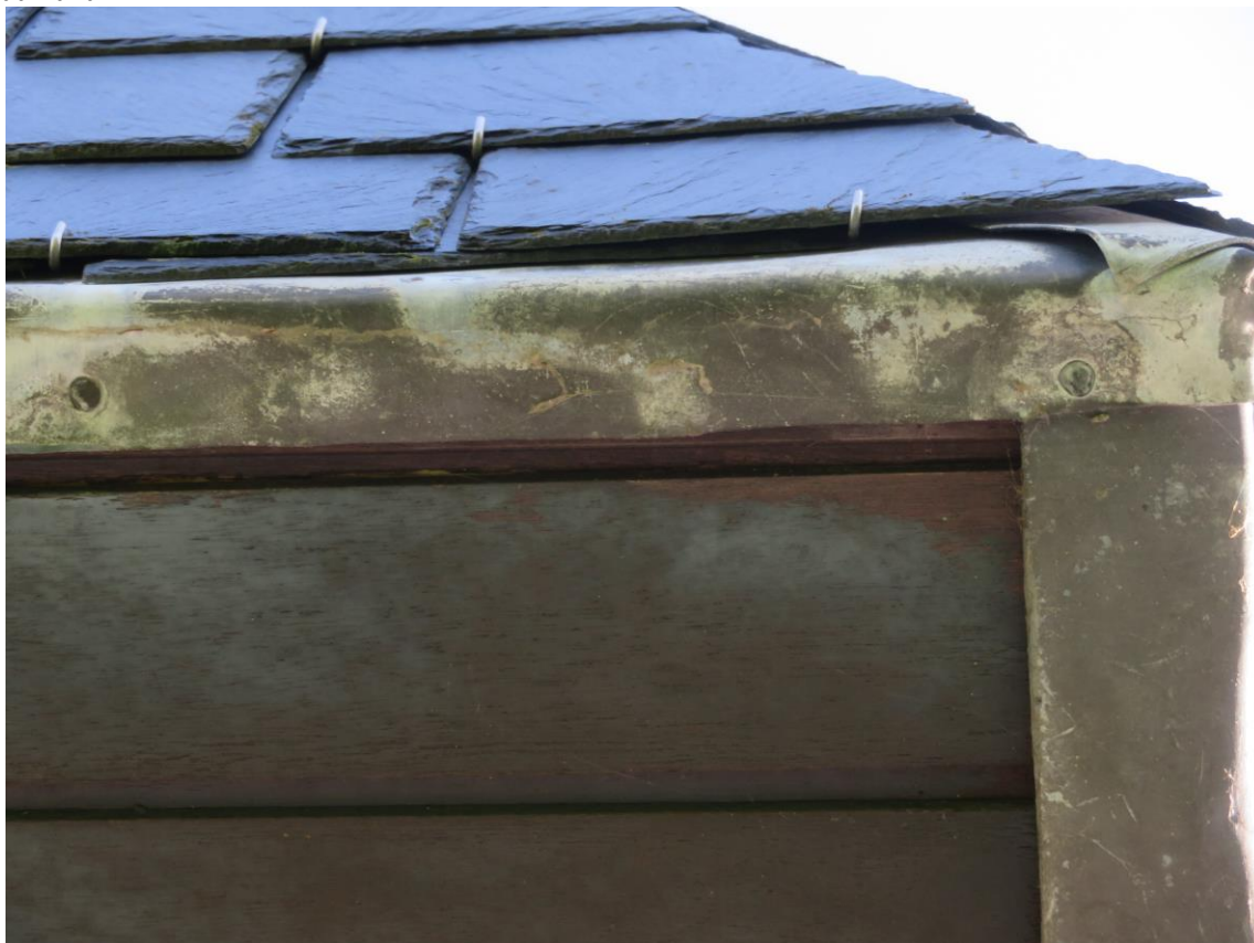
Op de plaatsen waar de gevel oversteekt is met hout afgewerkt. Kieren zijn hier niet aanwezig.
