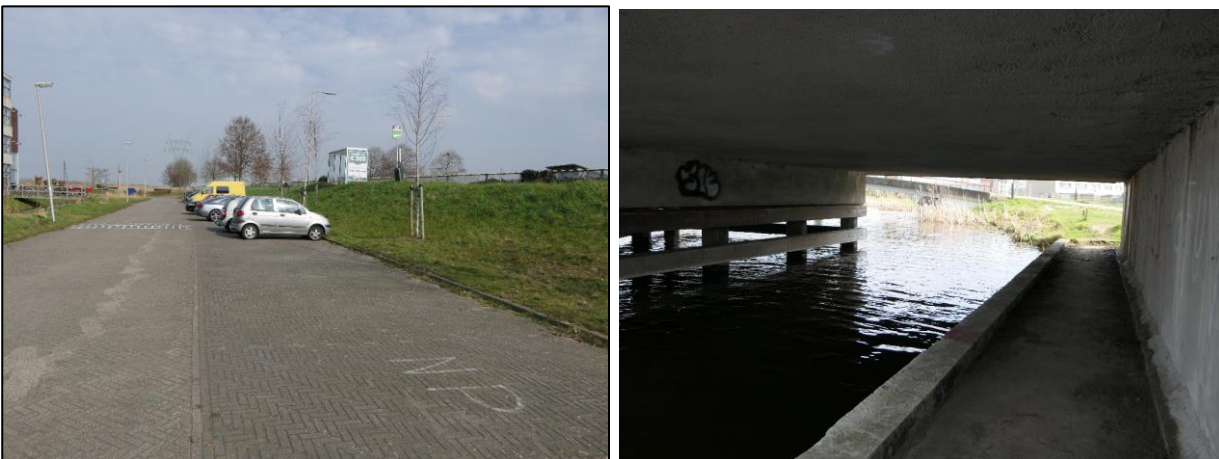
Figuur 6 (links). Parkeerplaatsen aan de Zijlstream, naar het oosten gezien. Figuur 7 (rechts). Faunapassage onder brug Dwarswatering, gezien naar het zuiden.
