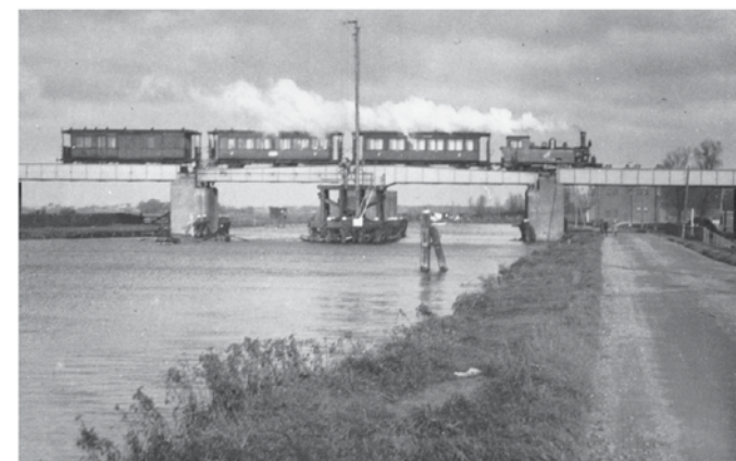
Spoorbrug over de Zijl (1930)
