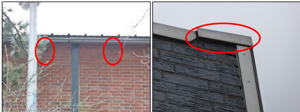
Open stootvoegen en ruimte onder de dakrand.
