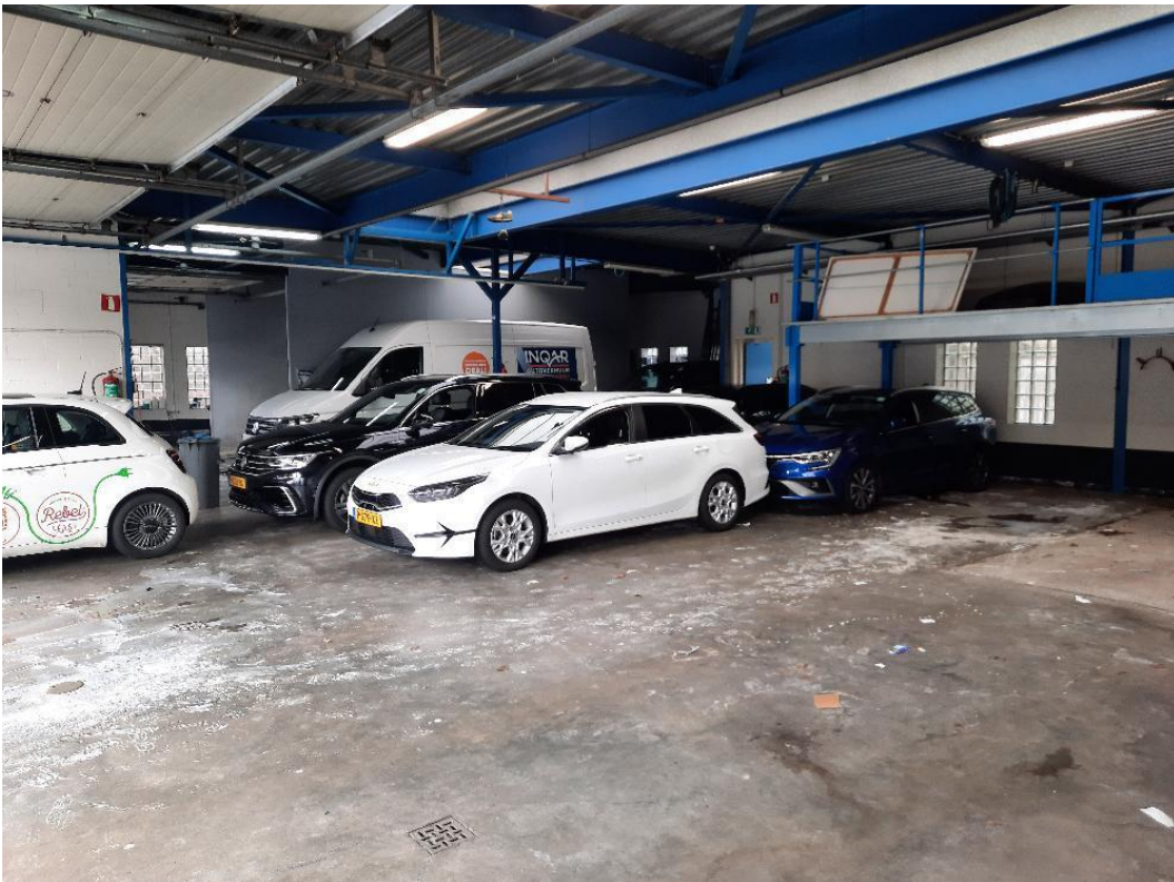
Foto 6: Betonvloer inpandig ter plaatse van de werkruimte.
