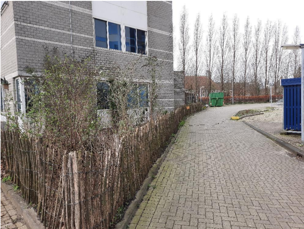
Foto 3: Noordoostzijde van de onderzoekslocatie met tegelverharding en groenstrook naast het kantoorpand.
