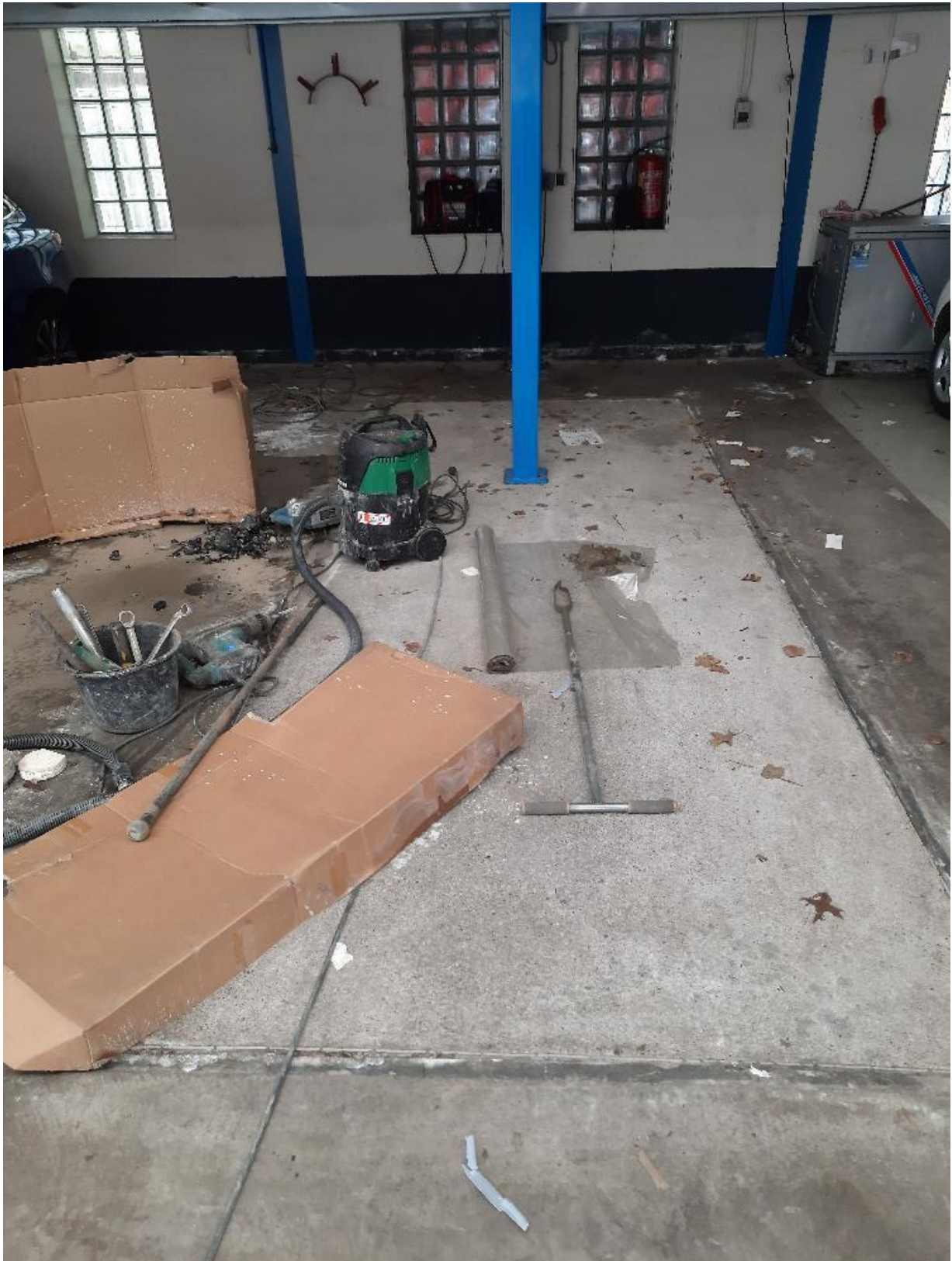
Foto 7: De voormalige smeerkuil is afgedekt met een betonnen deksel (in lichtere kleur beton).
