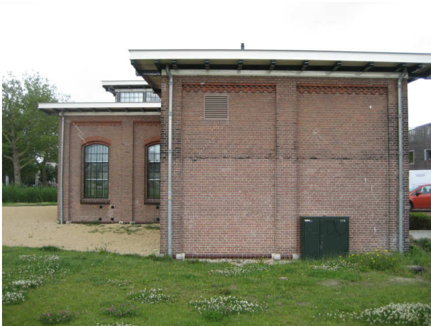
AFBEELDING 6 De bestaande oostgevel. [foto GVBarchitecten 2012]
