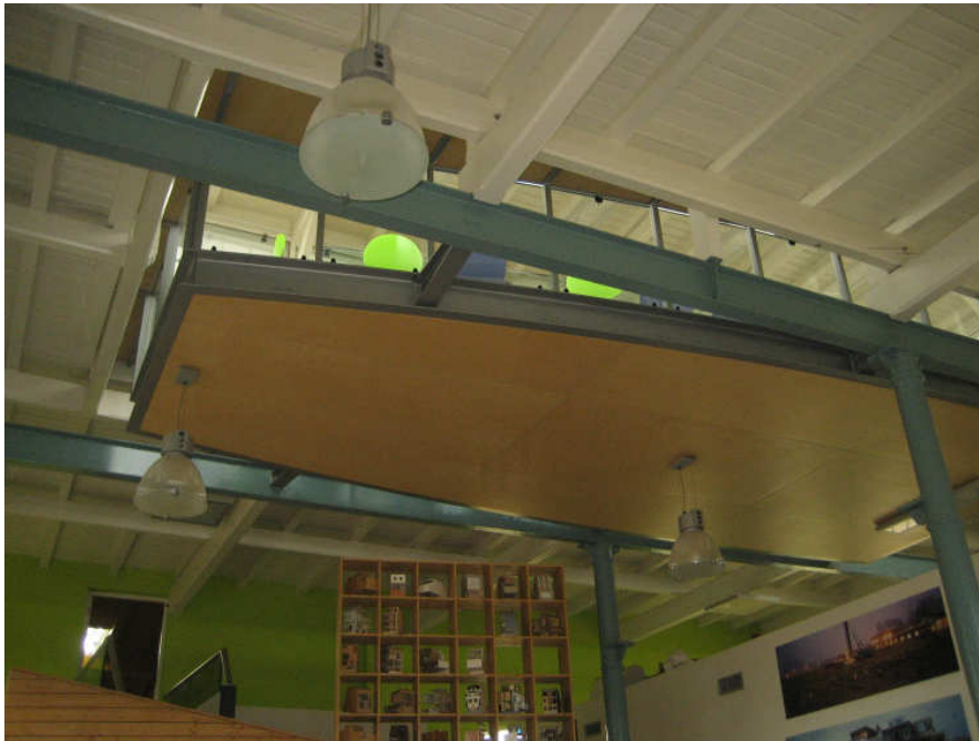
AFBEELDING 11 Verlaagde vloer van de tweede verdieping. [foto GVB architecten 2012]
