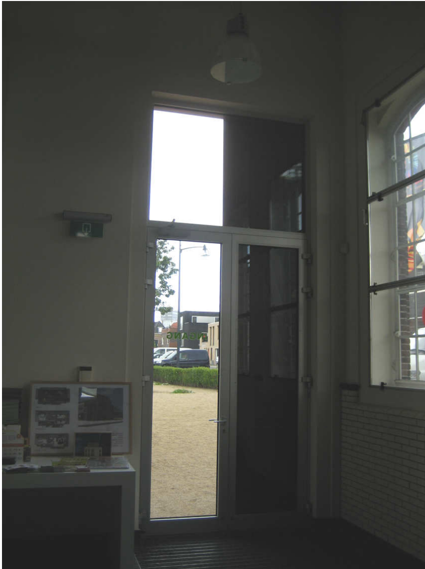
AFBEELDING 10 De bestaande toegangsdeuren van binnen uit. [foto GVB architecten 2012]
