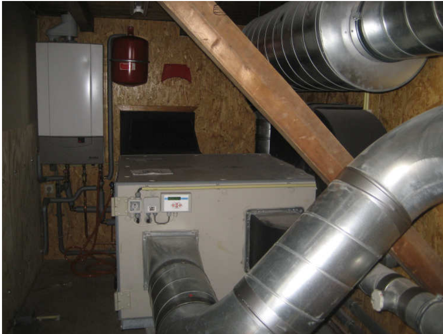
AFBEELDING 16 De bestaande installatieruimte [foto GVB architecten 2012]
