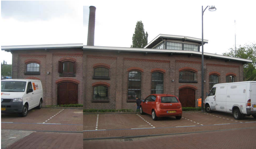
AFBEELDING 7 De bestaande noordgevel. [foto GVBarchitecten 2012]
