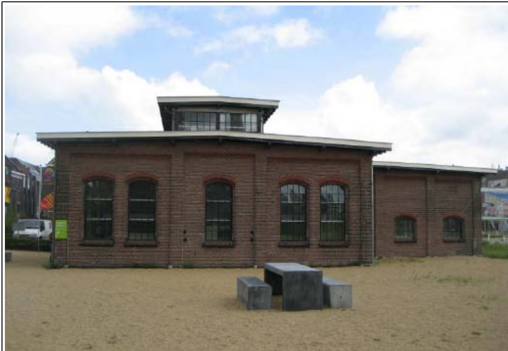
Bestaande zuidgevel Slachthuislaan 31
