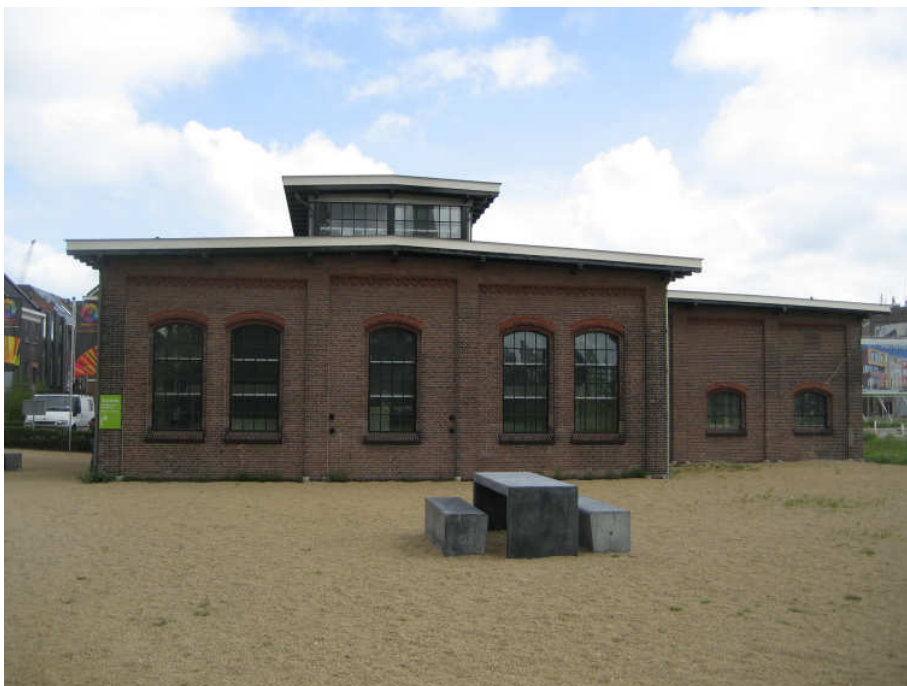
AFBEELDING 4 Hier afgebeeld de bestaande zuidgevel. In deze gevel komt de nieuwe pui en worden de kozijnen verlaagd. [foto GVBarchitecten 2012]
