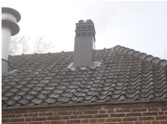
Foto 5: Impressie plangebied vanaf de westzijde van Lammenschansweg 6. Potentiële invliegopeningen voor huismussen, gierzwaluw en vleermuizen bij dakpannen, dakrand en schoorstenen.
