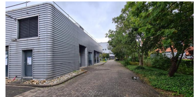
Figuur 6: Oostgevel van het kantoor
