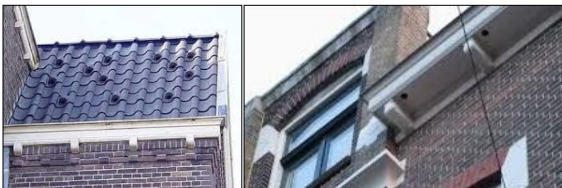
Figuur 13: Nestpan voor de gierzwaluw (links) en gaten in dakgootomlijsting (rechts).
