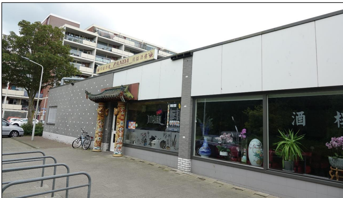
Figuur 2: Noordzijde van het winkelcentrum welke gesloopt zal worden met in de huidige situatie een Chinees restaurant.
