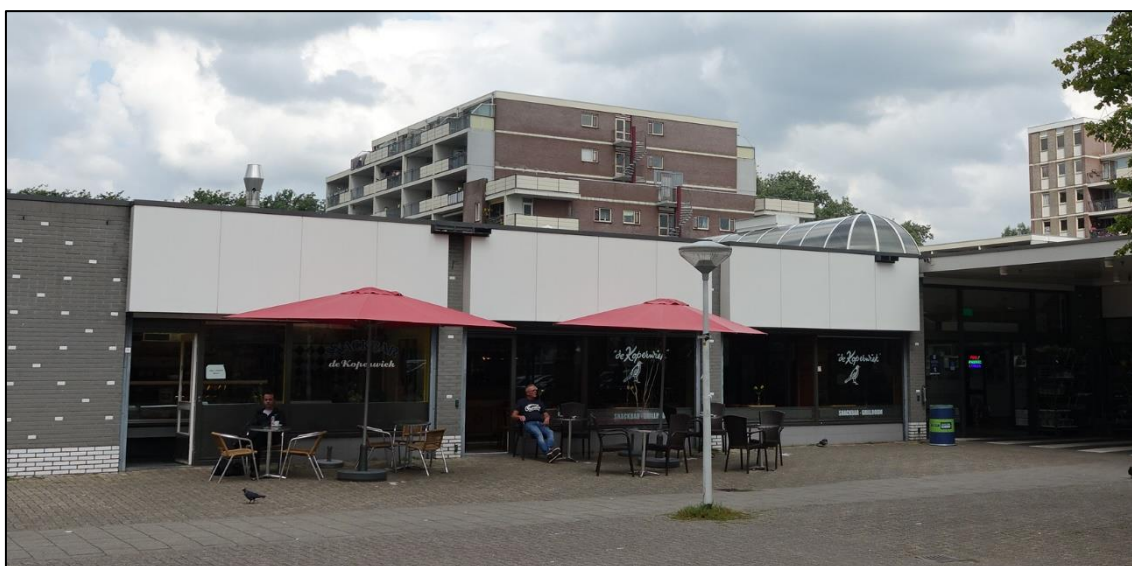
Figuur 20: De gevel van de snackbar welke is opgetrokken uit glaswerk en kunststof platen.
