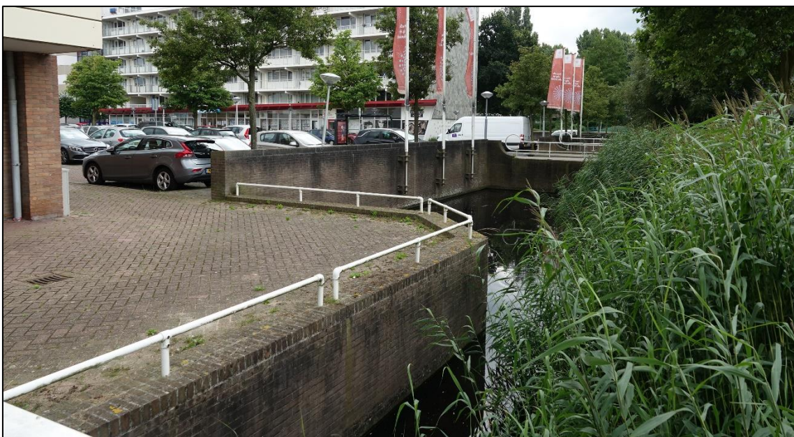
Figuur 6: De naastgelegen sloot waar de woontoren deels in komt te staan.
