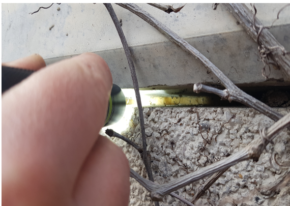
Glaswol in spouwmuur, direct achter dilatatievoeg
