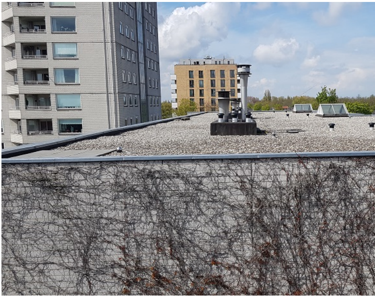
Dak en dakrand
