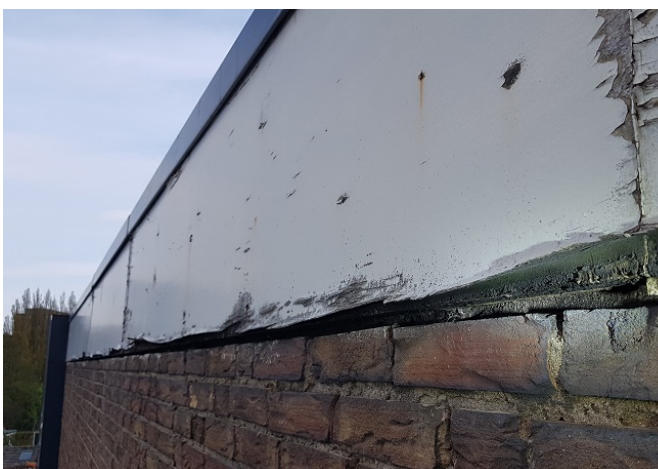
Houten boarding, dicht met cement, zonder toegankelijke kieren voor vleermuizen
