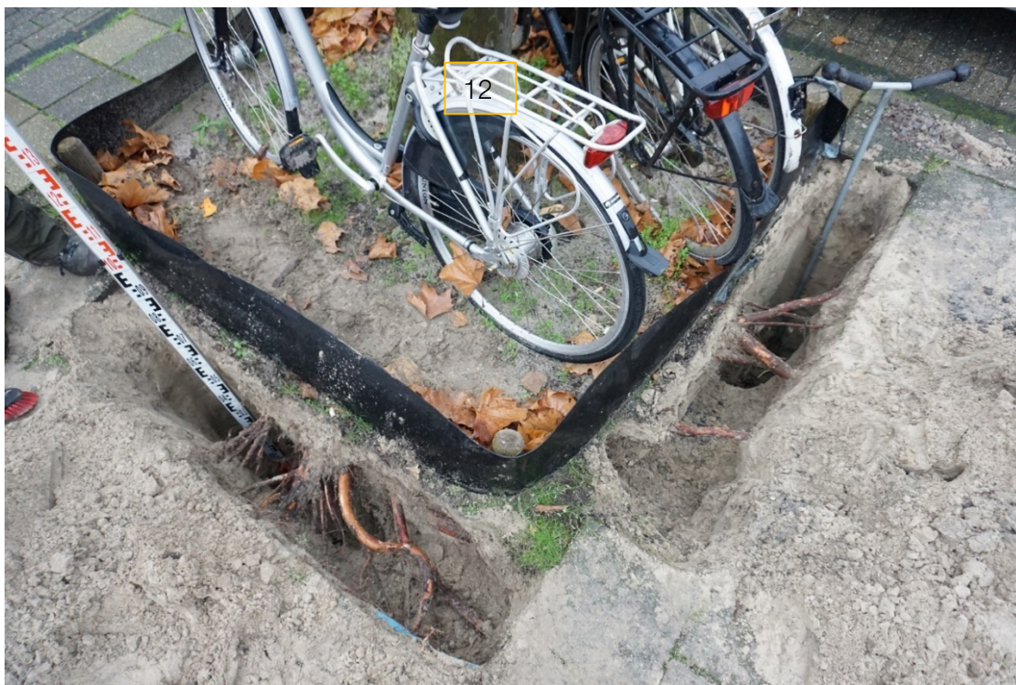
Foto 9: Beeld van groeiplaats bij gewone plataan met boomnummer 12, gegraven binnen de voorbereide kluit.
