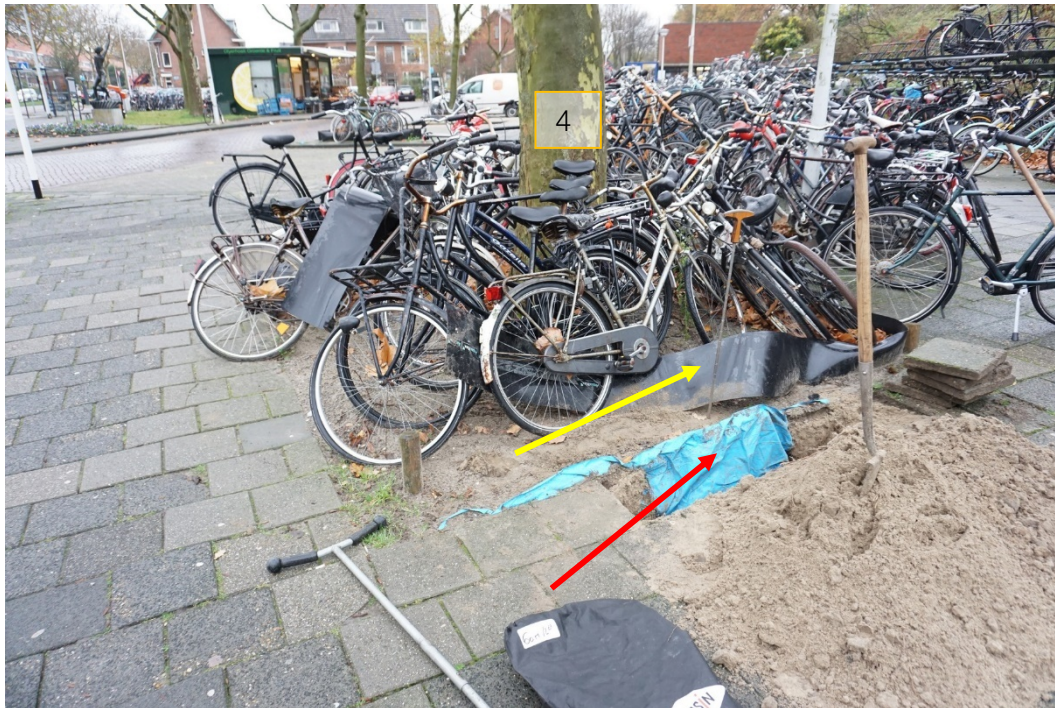
Foto 8: Beeld van groeiplaats bij gewone plataan met boomnummer 4. Met rode pijl is het blauwe plasticdoek weergegeven en met gele pijl de kunststof gietrand. De boom is duidelijk voorbereid.
