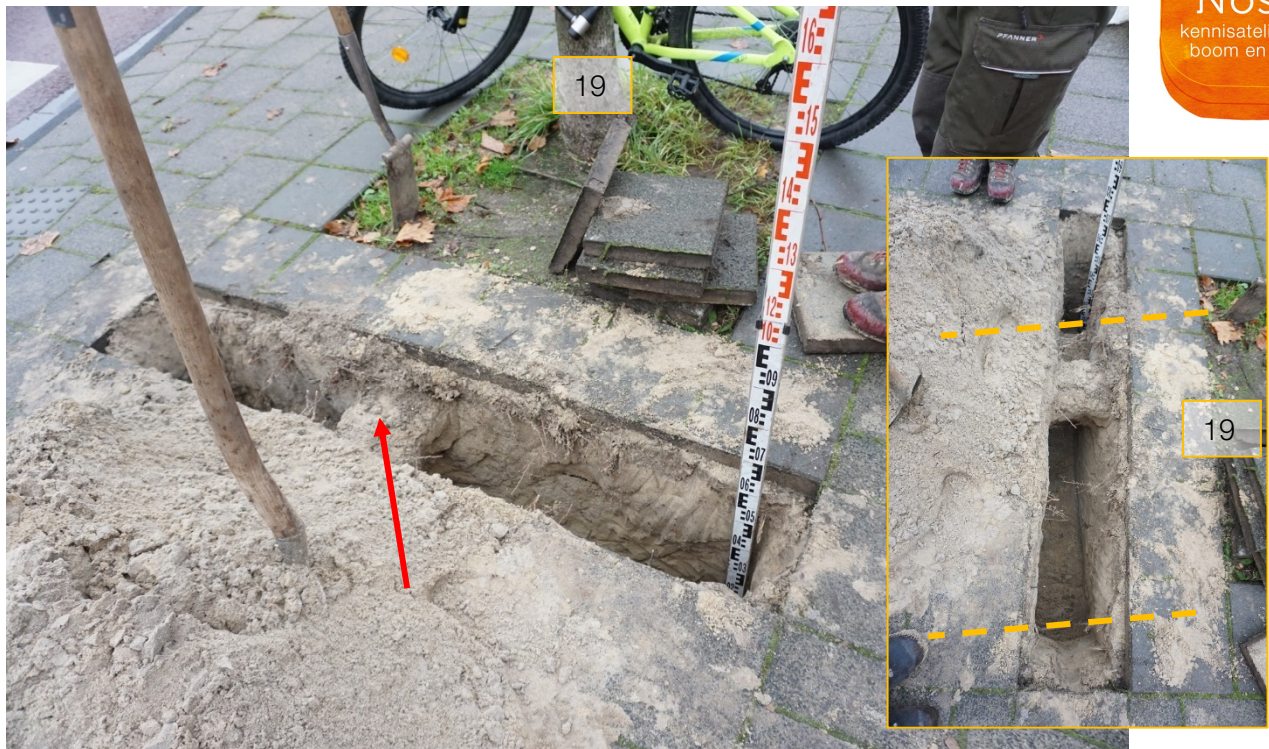
Foto 10 en 11: Beeld van groeiplaats bij bolesdoorn met boomnummer 19, met rode pijl de betonelement (links). De oranje gestreepte lijnen geven de ligging van datakabels weer (rechts).
