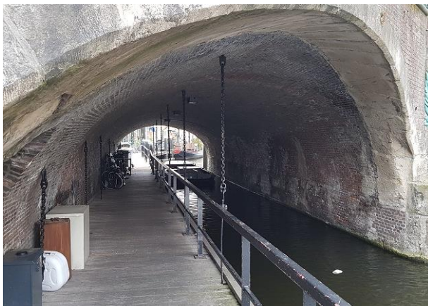
e) steiger onder de brug
