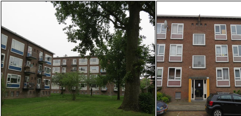
Figuur 2. Diverse portiekflats in het plangebied.
