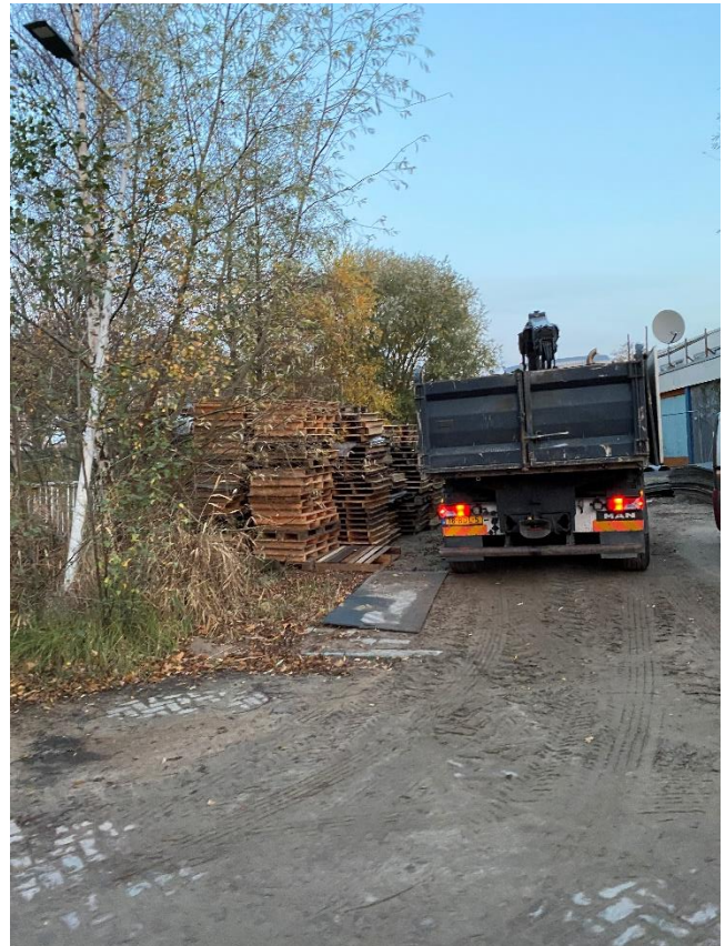
Figuur 3, werkzaamheden meetlocatie
