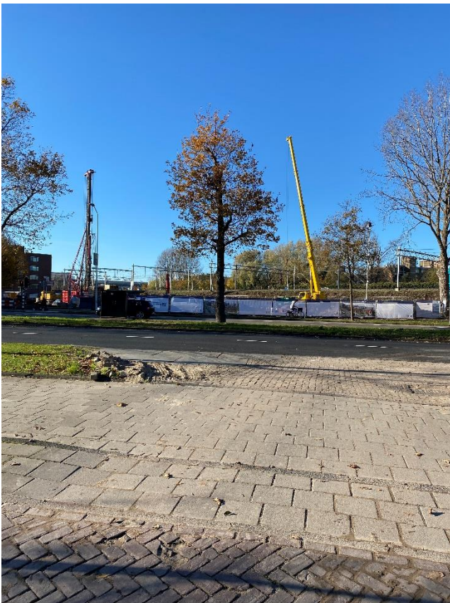
Figuur 2, werkzaamheden overzijde meetlocatie
