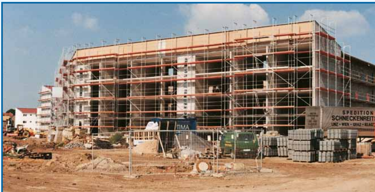
Bij het bouwen van een appartementencomplex was de keus voor FAAY isolatiewanden snel gemaakt.
