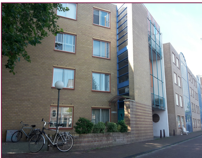
Foto 3: opening in niet te slopen deel van het gebouw
