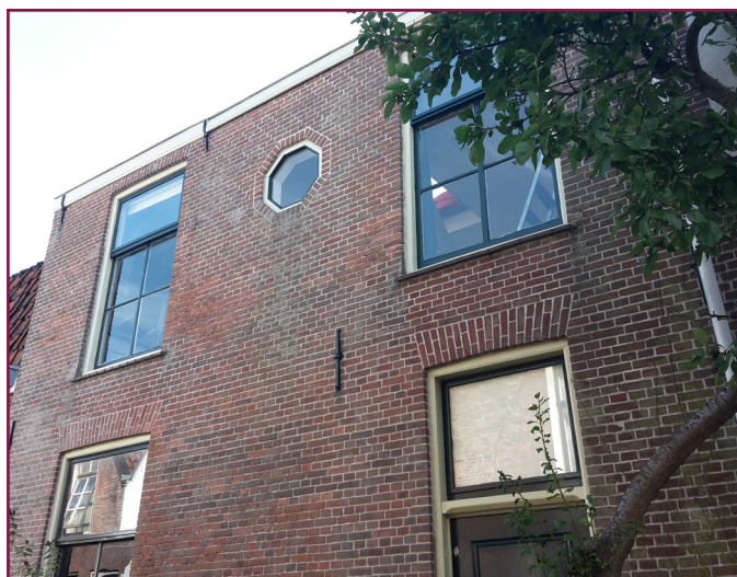
Foto 4: opening in te slopen deel van het gebouw
