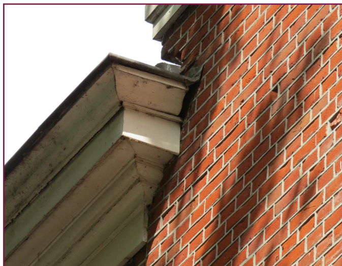
Foto 2: opening in te slopen deel van het gebouw
