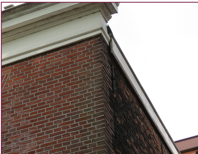
Foto 1: opening in niet te slopen deel van het gebouw
