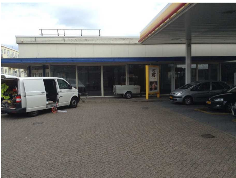
Buitenzijde Vijf Meilaan vanaf tankstation
