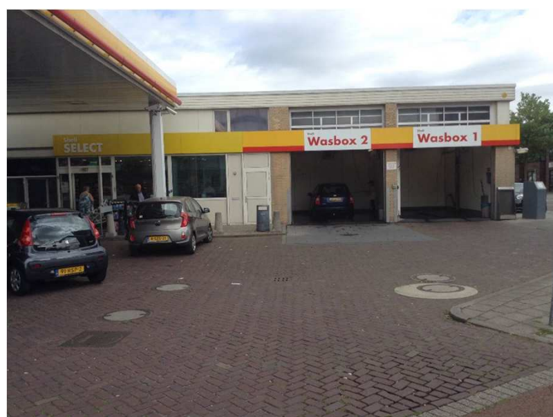
Buitenzijde Vijf Meilaan vanaf tankstation
