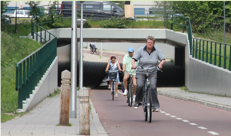
referenties ondergronds deel tunnel
