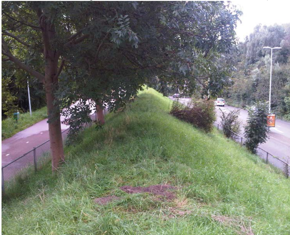
Foto 2 Noordzijde van geluidswal. Links is het fietspad en rechts de Dr. Lelylaan zichtbaar.
