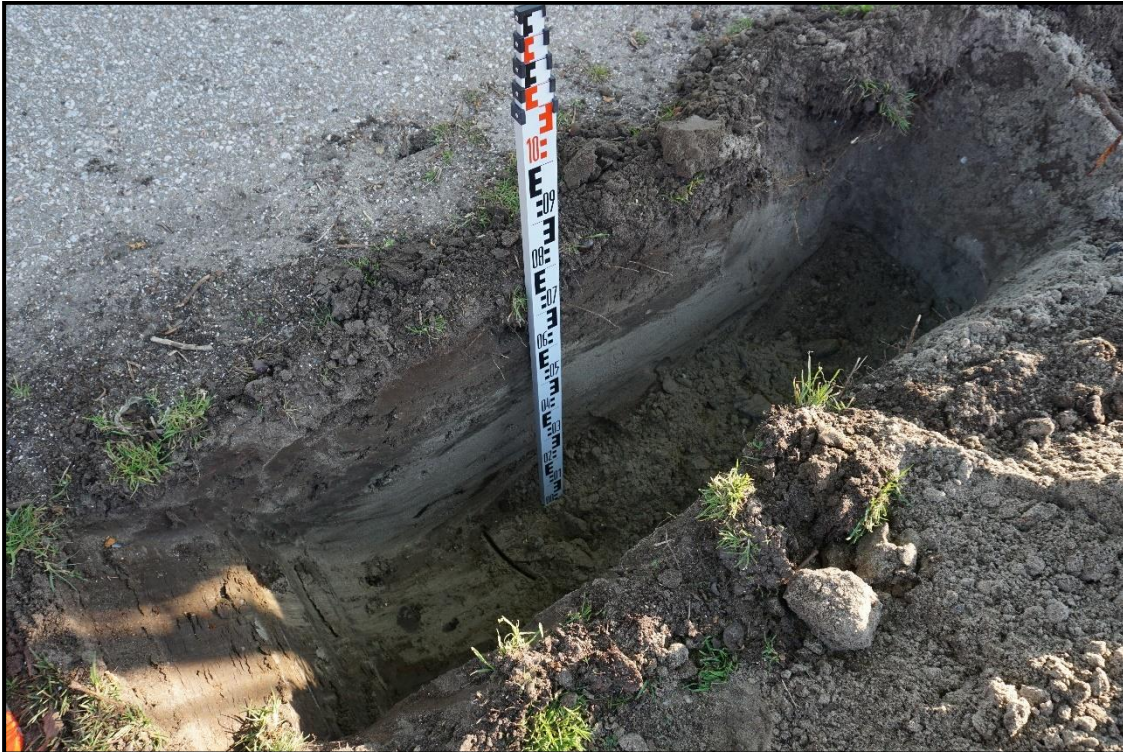
Foto 9: Sleuf 3 op 3 meter van het hart van boom 100 en 101, geen beworteling aan de zuidzijde.
