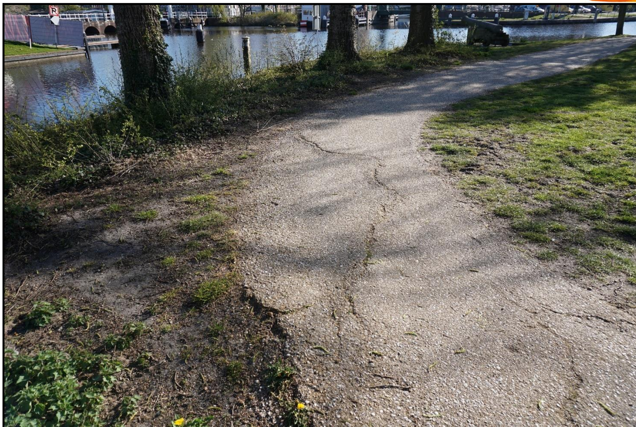
Foto 13: Wanneer bij de bomen 61-66 het maaiveld wordt verhoogd onder de nieuwe verharding, zullen de wortels gespaard worden.
