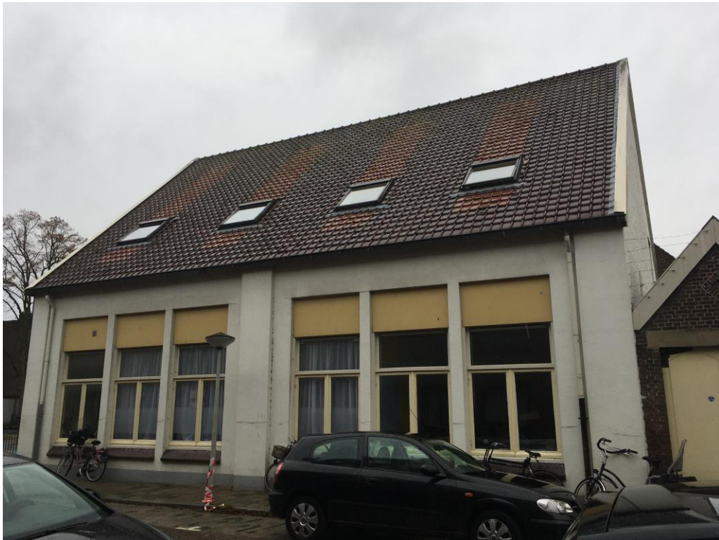
Figuur 1 De planlocatie is gelegen aan de Munnikenstraat 1-1D en Oosterstraat 16 te Leiden en bestaat uit een schoolgebouw, buurthuis en gymzaal. Hier de oostzijde van het buurthuis.
