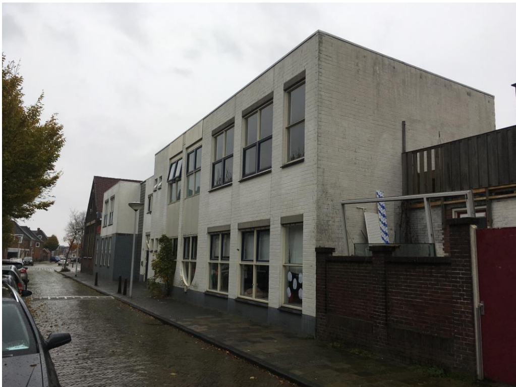
Figuur 2 De westzijde van het schoolgebouw.
