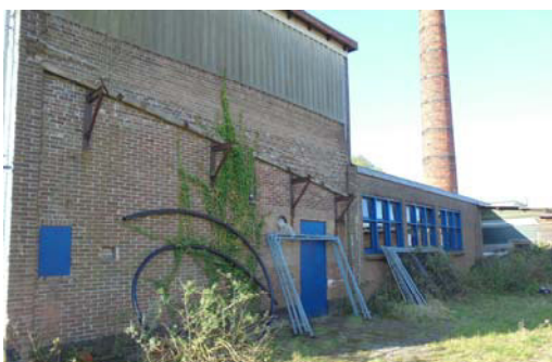
Foto 1 beeld van de onderzoekslocatie
