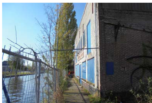
Foto 2 beeld van de onderzoekslocatie
