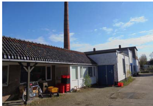
Foto 4 beeld van de onderzoekslocatie
