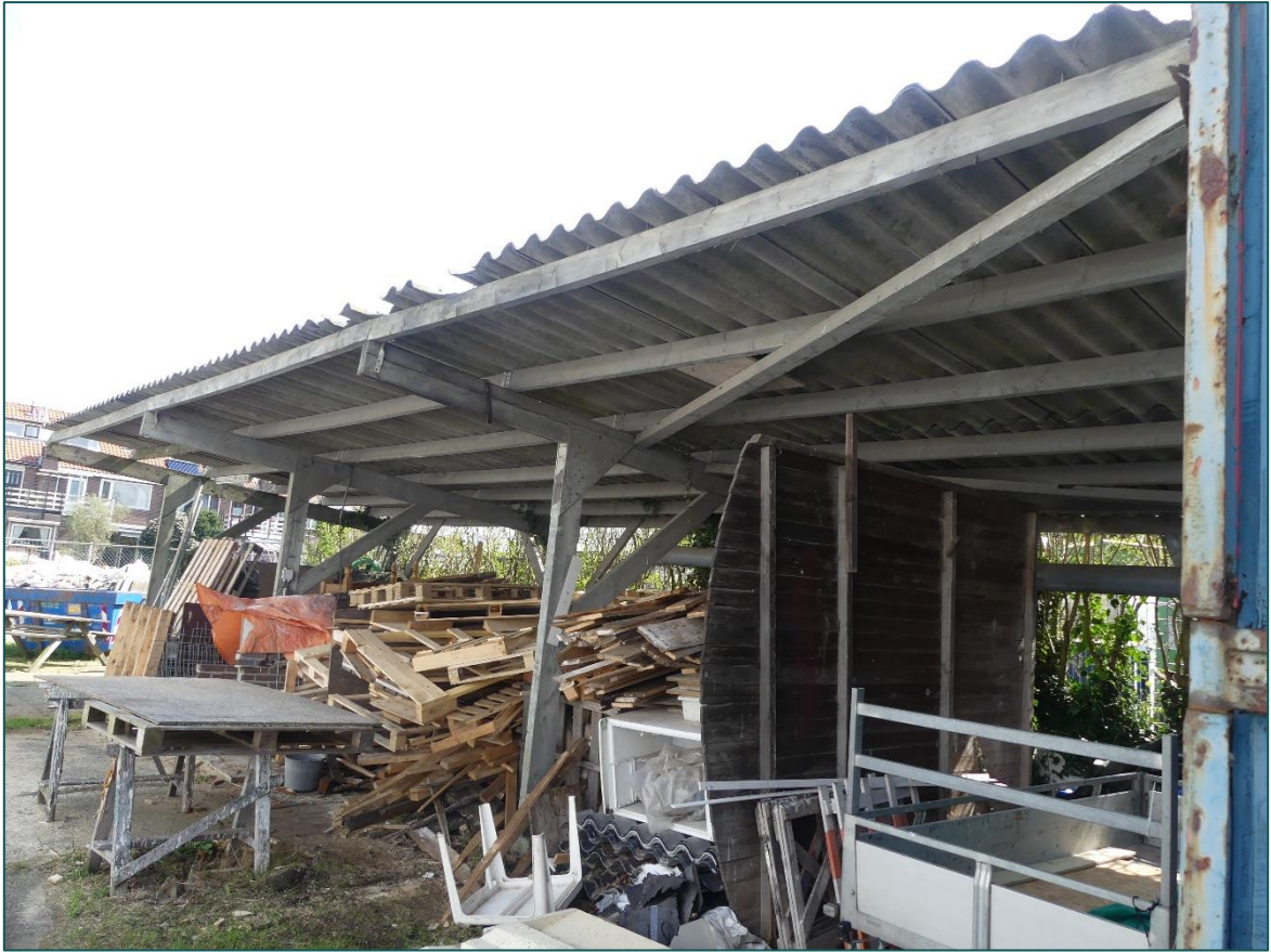
Figuur 5 Impressie van gebouw 7 op de planlocatie, opgebouwd uit golfplaten dak zonder dakbeschoot.
