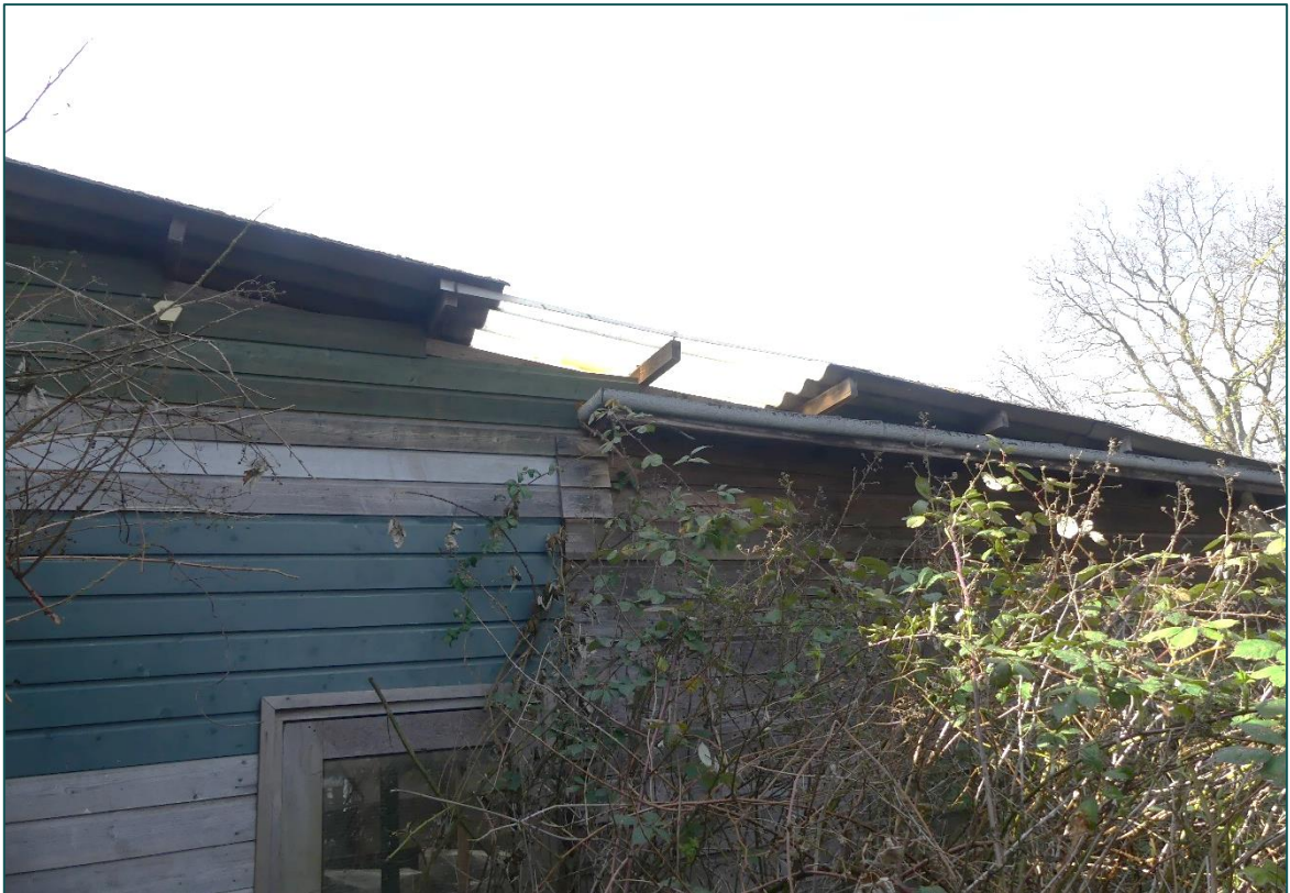
Figuur 6 Impressie van gebouw 8 op de planlocatie, opgebouwd uit golfplaten dak zonder dakbeschoot en houten gevels.
