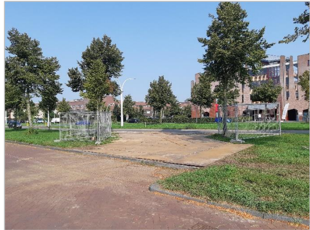
afb. 10: voorbeeld van het juist toepassen van rijplaten in combinatie met hekwerk.
