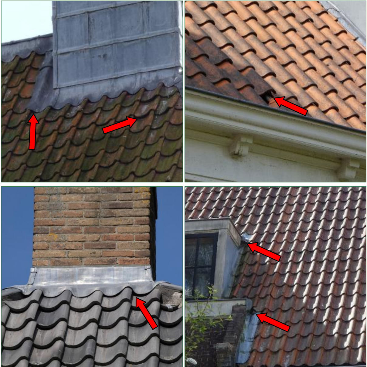
Figuur 4-1: De openingen onder de dakpannen en loodslabben van de bebouwing geven mogelijk toegang tot voor vleermuizen geschikte achterliggende ruimtes. De potentie bevindt zich verspreid over alle delen van de bebouwing.
