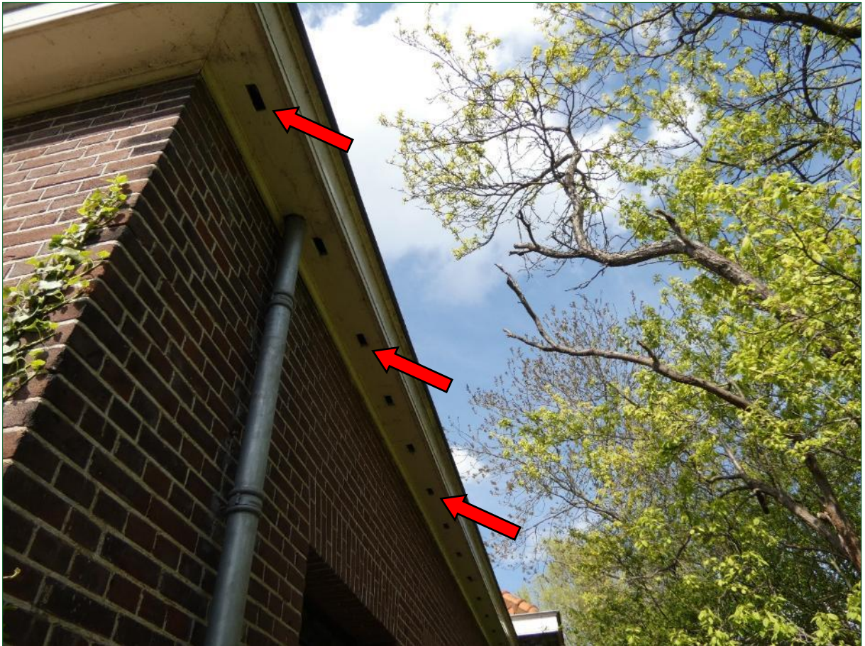
De openingen onder de gevelrand geven mogelijk toegang tot voor Gierzwaluw en Huismus geschikte achterliggende ruimtes.
