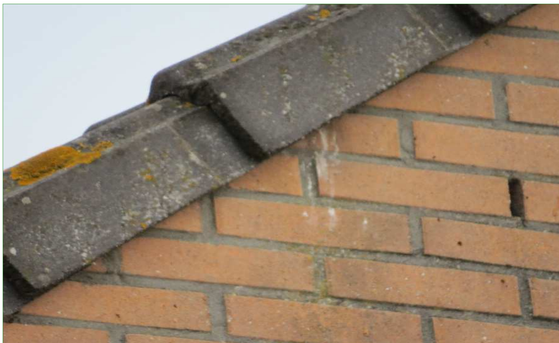
Typische invliegplek van Gierzwaluw onder een eind nokvorst (voorbeeldfoto, niet in plangebied!). Aan de hand van sporen op de muur zijn invlieglocaties op te sporen.
