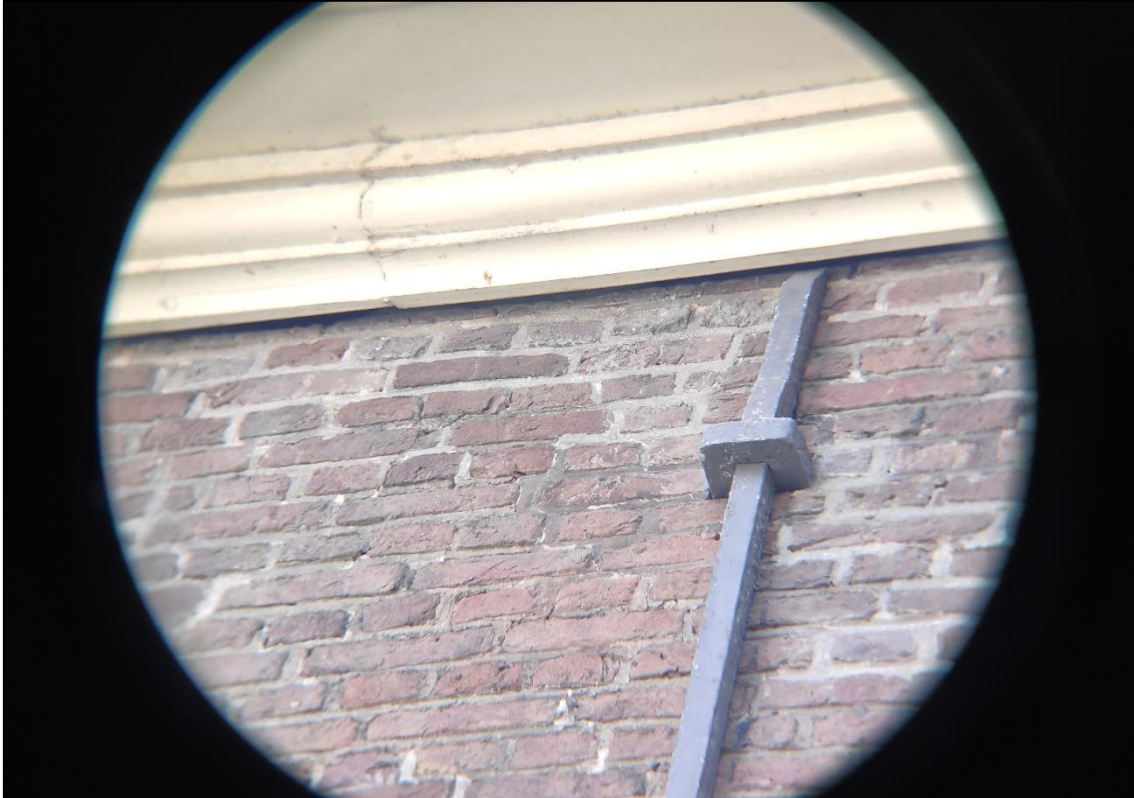
Figuur 8 ruimte tussen gevel en houtwerk
