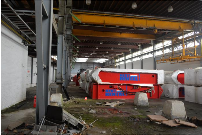
Afb. 52 (links) Overzicht van de ViHy-hal uit 1964, met de overgangstrook als aansluiting op de fabriek uit 1954-58. De gele loopkat dateert uit 1985 en vooraan is de opstelplaats van de vloerplatenmachine uit dezelfde periode. Afb. 53 (rechts) De ViHy-hal uit 1964 heeft een dragend staalskelet en bakstenen gevels met lichtstrook bovenaan.
