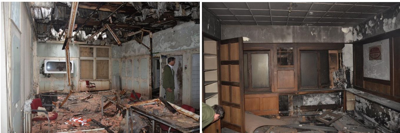
Afb. 26 en 27 kantine begane grond en directiekantoor eerste verdieping.
