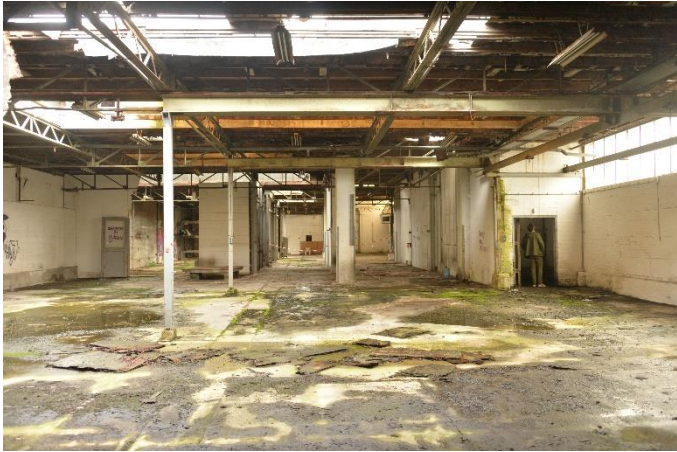
Afb. 46 en 47 De fabriek uit 1954-58 met de originele ijzeren draagconstructie (deels aangepast met I-liggers) en een origineel geveldeel met lichtstrook. De betonnen kolommen zijn van de onderbouw van de silo's uit 1965-66. De verhoging met zadeldak dateert uit 1983-86.
