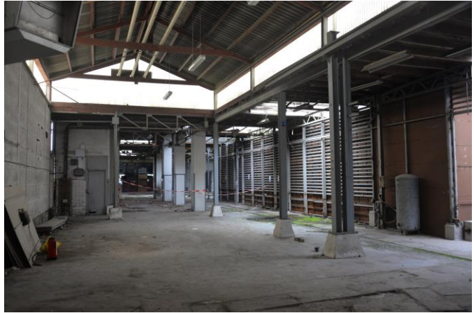
Afb. 46 en 47 De fabriek uit 1954-58 met de originele ijzeren draagconstructie (deels aangepast met I-liggers) en een origineel geveldeel met lichtstrook. De betonnen kolommen zijn van de onderbouw van de silo's uit 1965-66. De verhoging met zadeldak dateert uit 1983-86.
