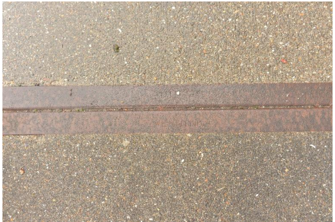
Afb. 75 en 76 Details van vloerplaten met de bedrijfsnaam Wernink er op gelast (ouder model) en ingestant (jonger).
