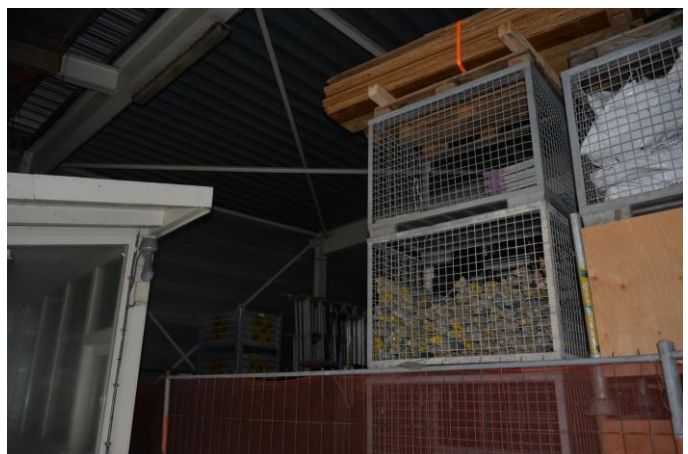
Afb. 56 (links) Overzicht vanuit de loods uit 1999 naar de ViHy-hal uit 1964. De loods heeft een dragend staalskelet en wanden van damwandprofiel. Afb. 57 (rechts) Interieur van de uitbreiding uit 2000 met dragend staalskelet en wanden van damwandprofiel.
