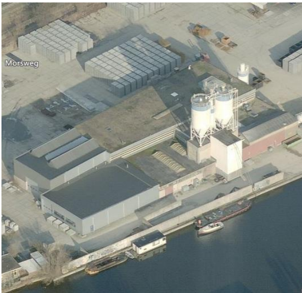
Afb. 31 en 32 Overzichten van de fabriek omstreeks 2005 en 1958 (links Bingmaps ca. 2005 en rechts detail foto KLM Aerocarto, ELO PV_PV2826.3, zie ook afb. 8). Op afb. 31 is het lagere deel met de daklichten haaks op de Rijn het oudste fabrieksgebouw uit 1954-58 (vergelijk afb. 32 uit 1958). Op het oudste fabrieksgedeelte zijn in 1965 twee silo's en een bunker toegevoegd, in 1966 de verhoogde lichtstraat en op de hoek in 1983-86 het verhoogde zadeldak. Parallel aan het oudste fabrieksgedeelte staat de grote hal uit 1965 met naast staande silo en bunkers uit circa 1985. De grijze bedrijfshallen met platte daken dateren uit 1999 en 2000.
