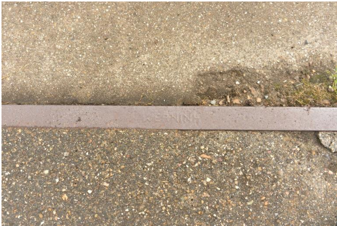
Afb. 75 en 76 Details van vloerplaten met de bedrijfsnaam Wernink er op gelast (ouder model) en ingestant (jonger).
