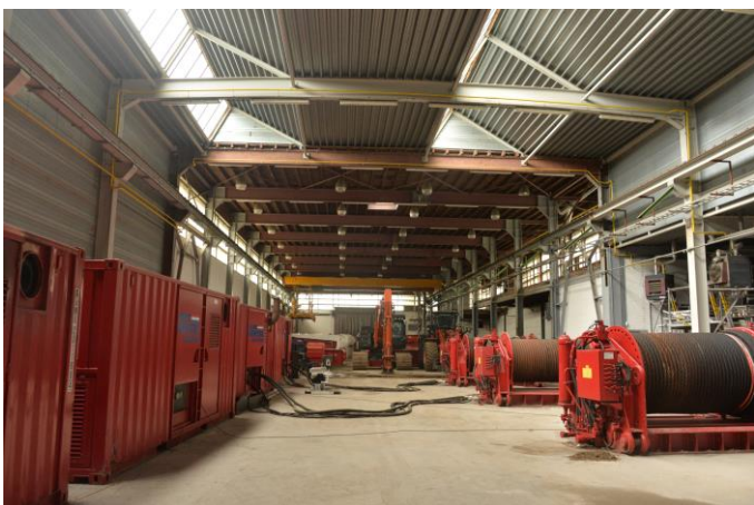
Afb. 56 (links) Overzicht vanuit de loods uit 1999 naar de ViHy-hal uit 1964. De loods heeft een dragend staalskelet en wanden van damwandprofiel. Afb. 57 (rechts) Interieur van de uitbreiding uit 2000 met dragend staalskelet en wanden van damwandprofiel.
