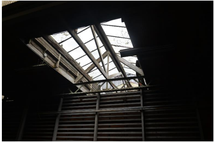
Afb. 48 (links) Detail van de samengestelde ijzeren draagconstructie van de fabriek uit 1954-58. Het grijze frame met de horizontale liggers betreft een droogrek van de betontegelmachine uit 1983-86.
