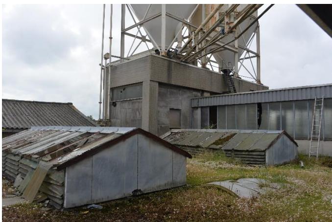
Afb. 44 (links) Dak van fabriek uit 1954-58 met originele bovenlichten, de silo's en lichtstraat uit 1965-66 en het zadeldak met golfplaat uit 1983-86.
