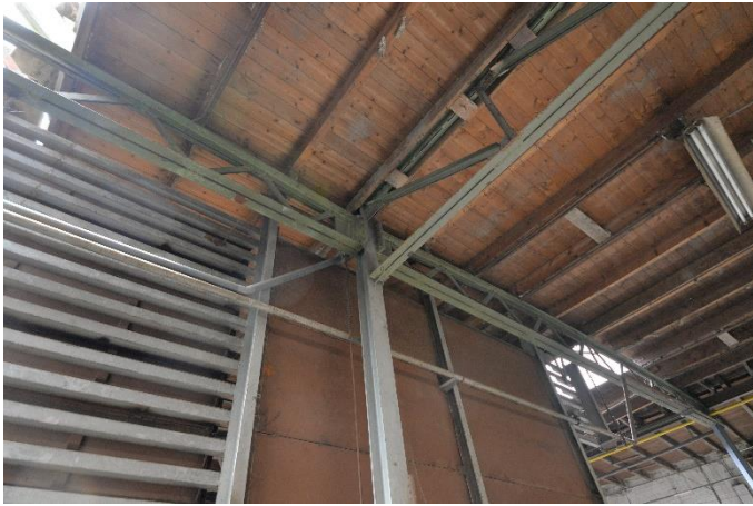
Afb. 48 (links) Detail van de samengestelde ijzeren draagconstructie van de fabriek uit 1954-58. Het grijze frame met de horizontale liggers betreft een droogrek van de betontegelmachine uit 1983-86.
