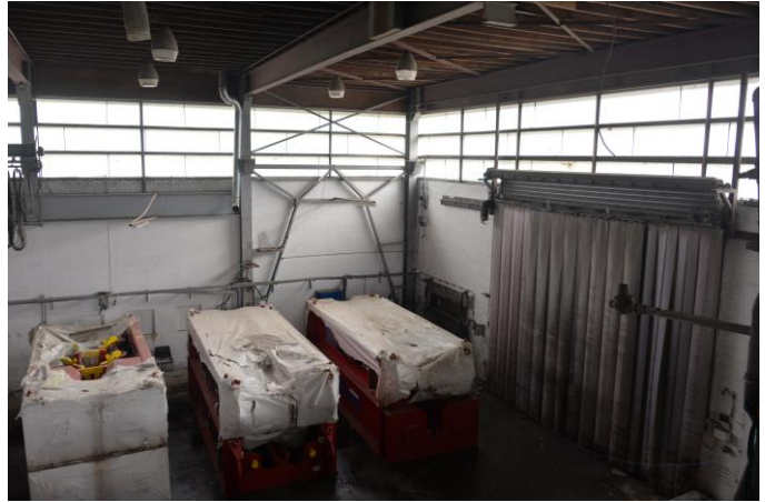
Afb. 52 (links) Overzicht van de ViHy-hal uit 1964, met de overgangstrook als aansluiting op de fabriek uit 1954-58. De gele loopkat dateert uit 1985 en vooraan is de opstelplaats van de vloerplatenmachine uit dezelfde periode. Afb. 53 (rechts) De ViHy-hal uit 1964 heeft een dragend staalskelet en bakstenen gevels met lichtstrook bovenaan.
