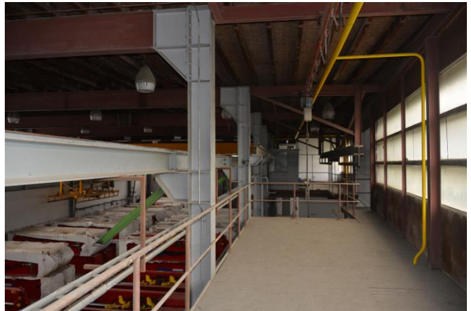
Afb. 54 en 55. Overgangszone met tussenvloer tussen ViHy-hal uit 1964 en de lagere fabriek uit 1954-58. De tussenvloer met vide hebben verband met de transportzone van de silo's naar de ViHy-machine in de loods uit 1965.
