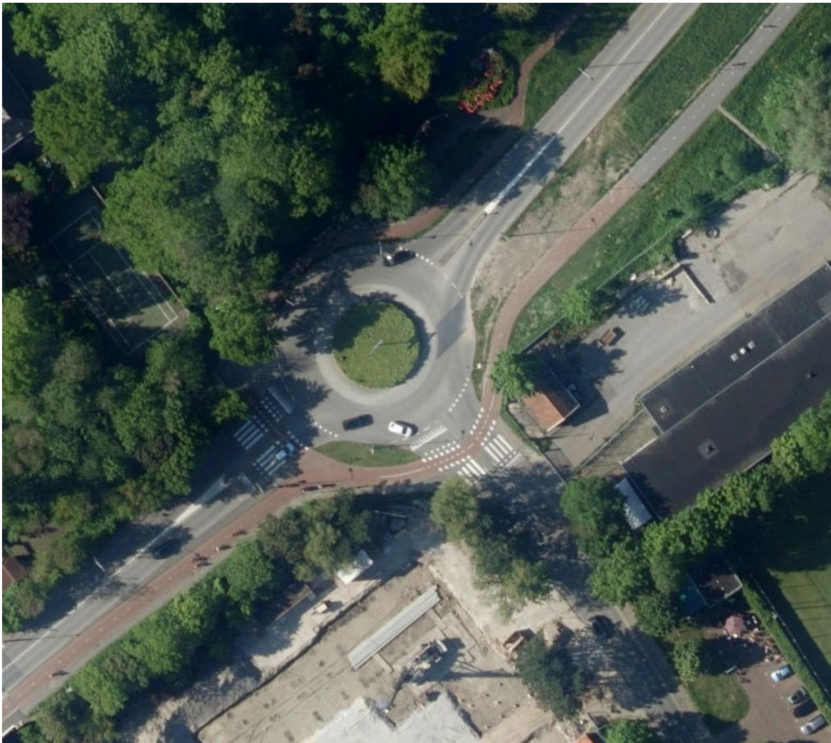
Figuur 8-1: Luchtfoto rotonde Haagse Schouwweg – Hoge Morsweg
