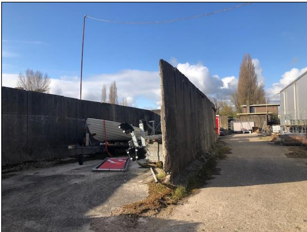
Figuur 26. De betonnen afscheidingen aan de waterzijde.
