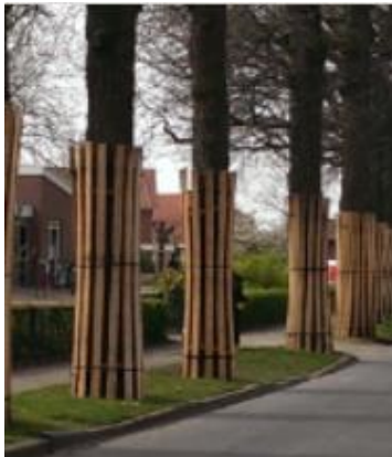
Afbeelding 19. Voorbeeld van stambescherming
