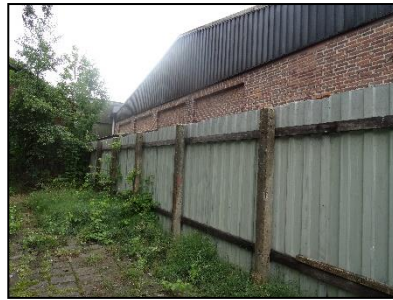
Figuur 10. Noordoostzijde (achterzijde van autobedrijf) van de onderzoekslocatie.
